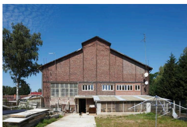
Seule halle de fabrication conservée de l'usine. Phot. Hubert Bouvet IVR31_20105900346NUCA
