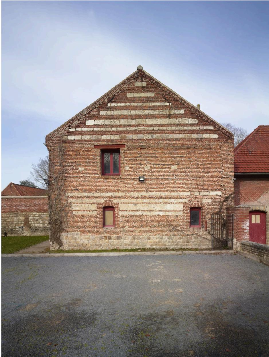
Mur pignon du bâtiment sud-ouest traité partiellement en rouges barres. Présence d'un linteau métallique.
