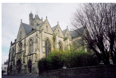
Vue de trois-quarts. Phot. Gilles-Henri Bailly IVR22_20158005647NUCA
