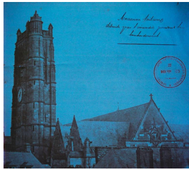
Ancienne toiture détruite par l'incendie pendant le bombardement, 22 décembre 1873 (AD Somme ; 99 O 2998). Phot. Gilles-Henri Bailly IVR22_20158005651NUCA
