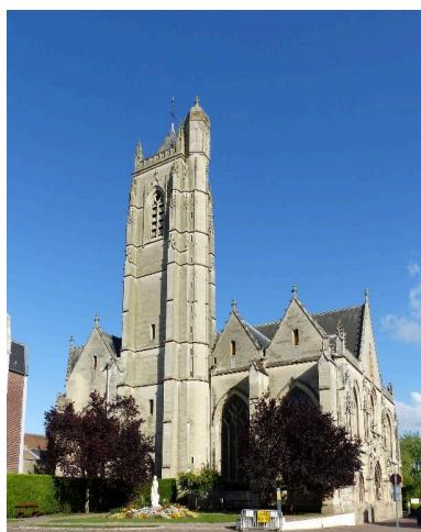
Vue générale, depuis la Grande place. Phot. Isabelle Barbedor IVR32_20178005206NUCA
