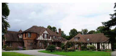
Élévations antérieures. Phot. Marie-Laure Monnehay-Vulliet IVR22_20128001071NUC2A
