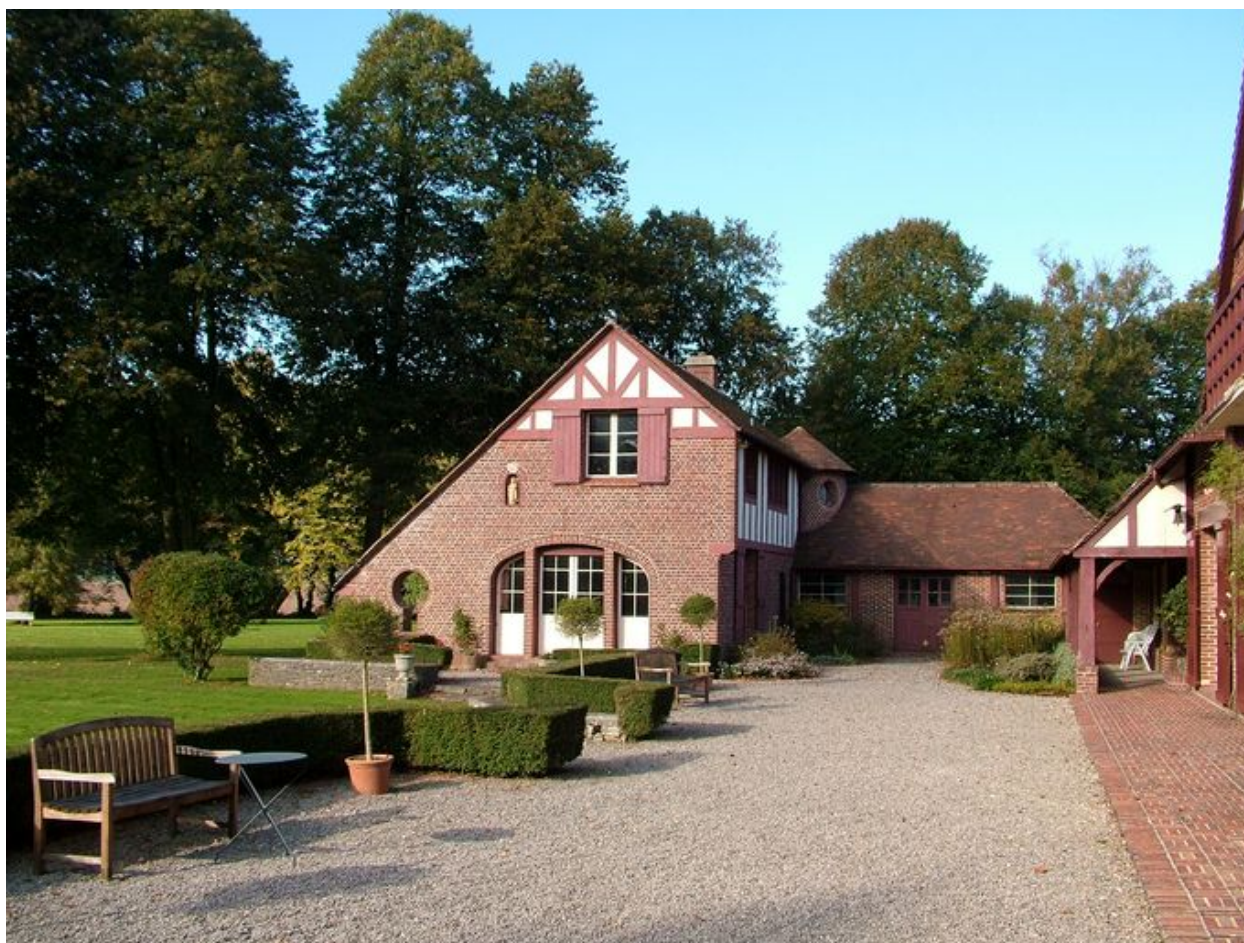
Bâtiment en retour d'équerre et pavillon postérieur.
