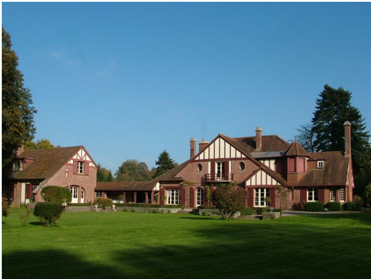
Vue générale depuis l'arrière.
