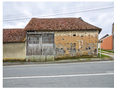
Vue d'une des granges le long de la rue, depuis le nord. Phot. Thierry Lefébure IVR32_20258000541NUCA
