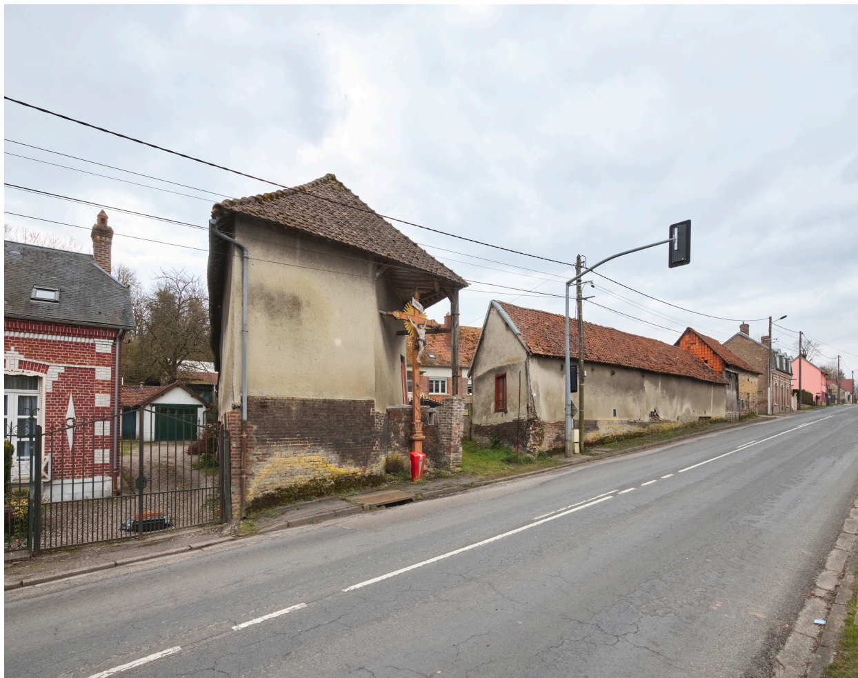
Vue des bâtiments le long de la rue, depuis le nord.
