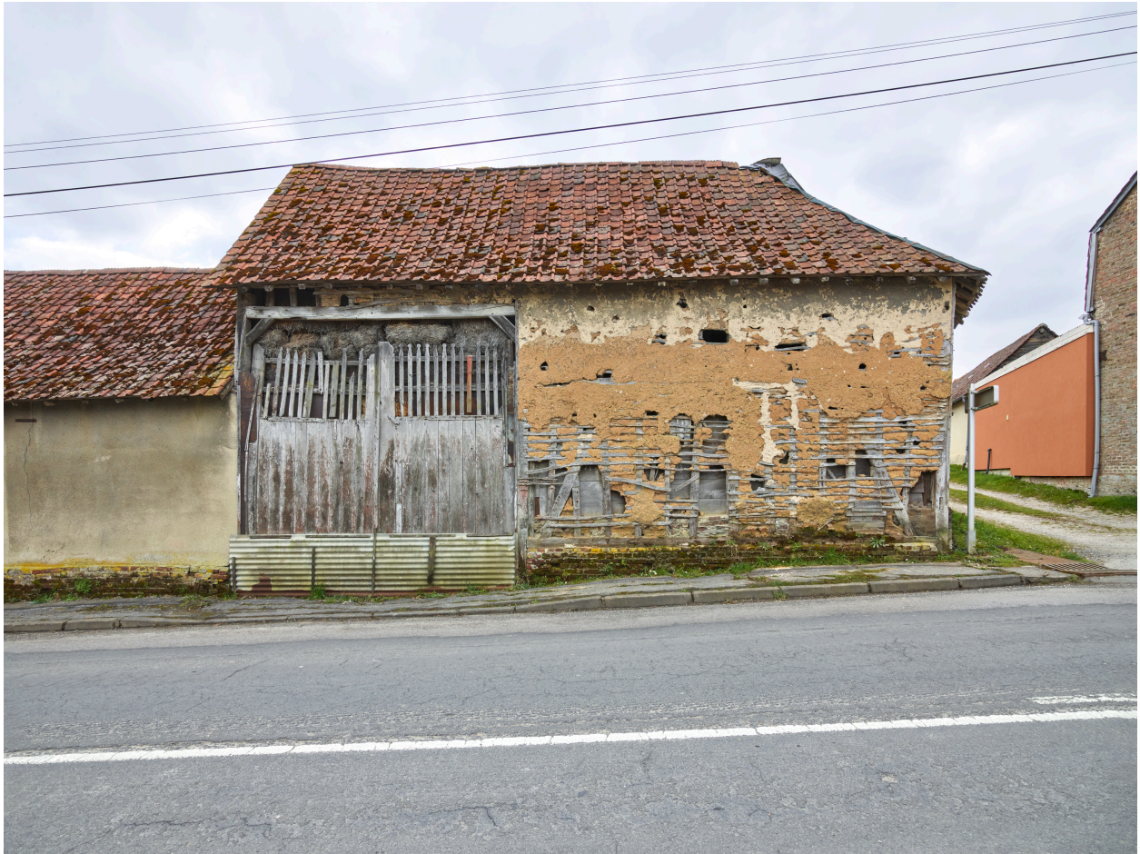
Vue d'une des granges le long de la rue, depuis le nord.
