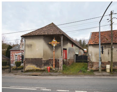
Vue de l'entrée de la ferme, depuis le nord. Phot. Thierry Lefébure IVR32_20258000536NUCA
