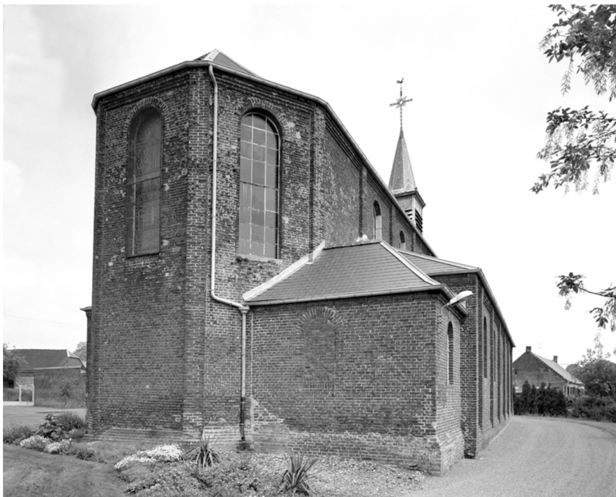
Vue d'ensemble du chevet et de l'élévation sud-ouest.
