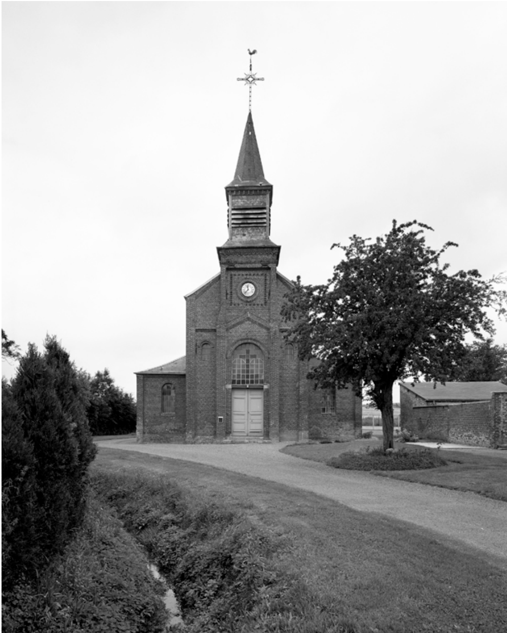
Vue générale de la façade.
