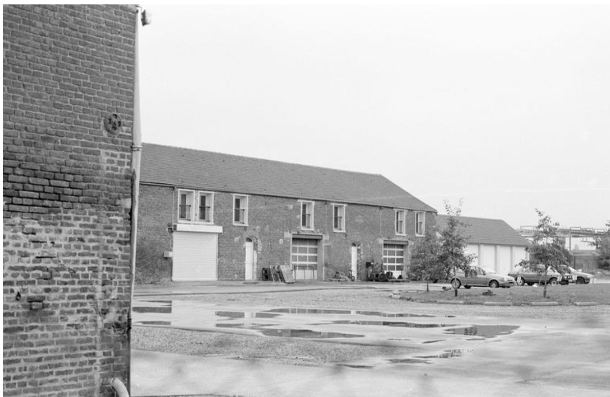
Façade sur cour de l'ancienne bouverie.
