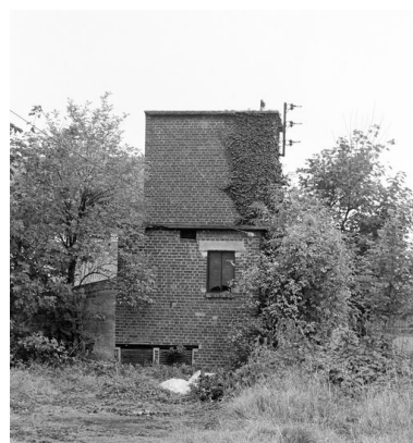
Transformateur électrique. Phot. Bertrand Fournier
