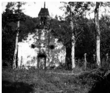
Façade de l'église, 1947 (archives privées). Repro. Marie- Laure Monnehay-Vulliet IVR22_20118000137NUC2A
