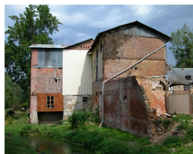
Façade sud-est du moulin et de sa cage en saillie.
