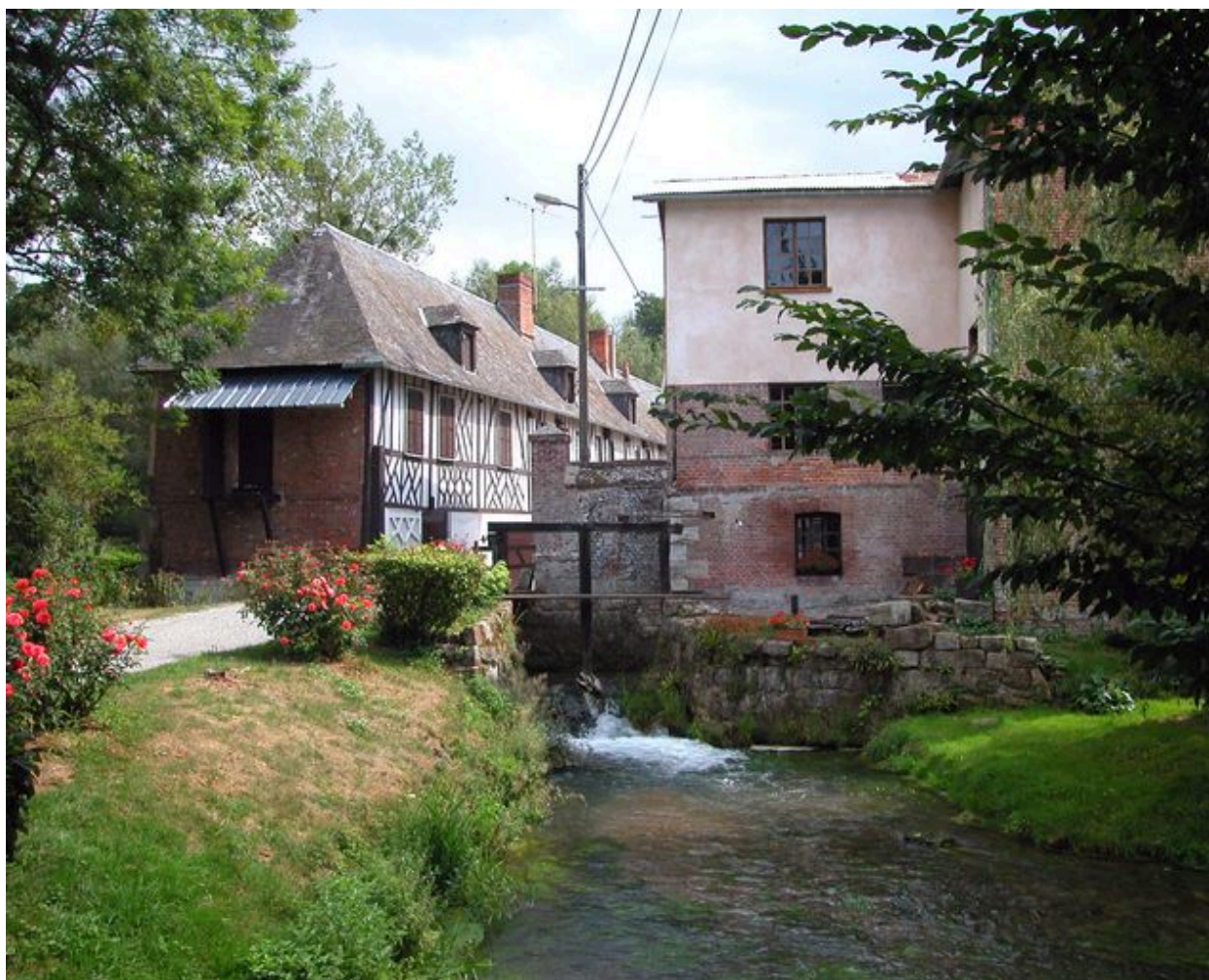
Vue d'ensemble avec le vannage de décharge et le déversoir
