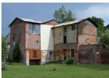
Vue d'ensemble sud du moulin.
