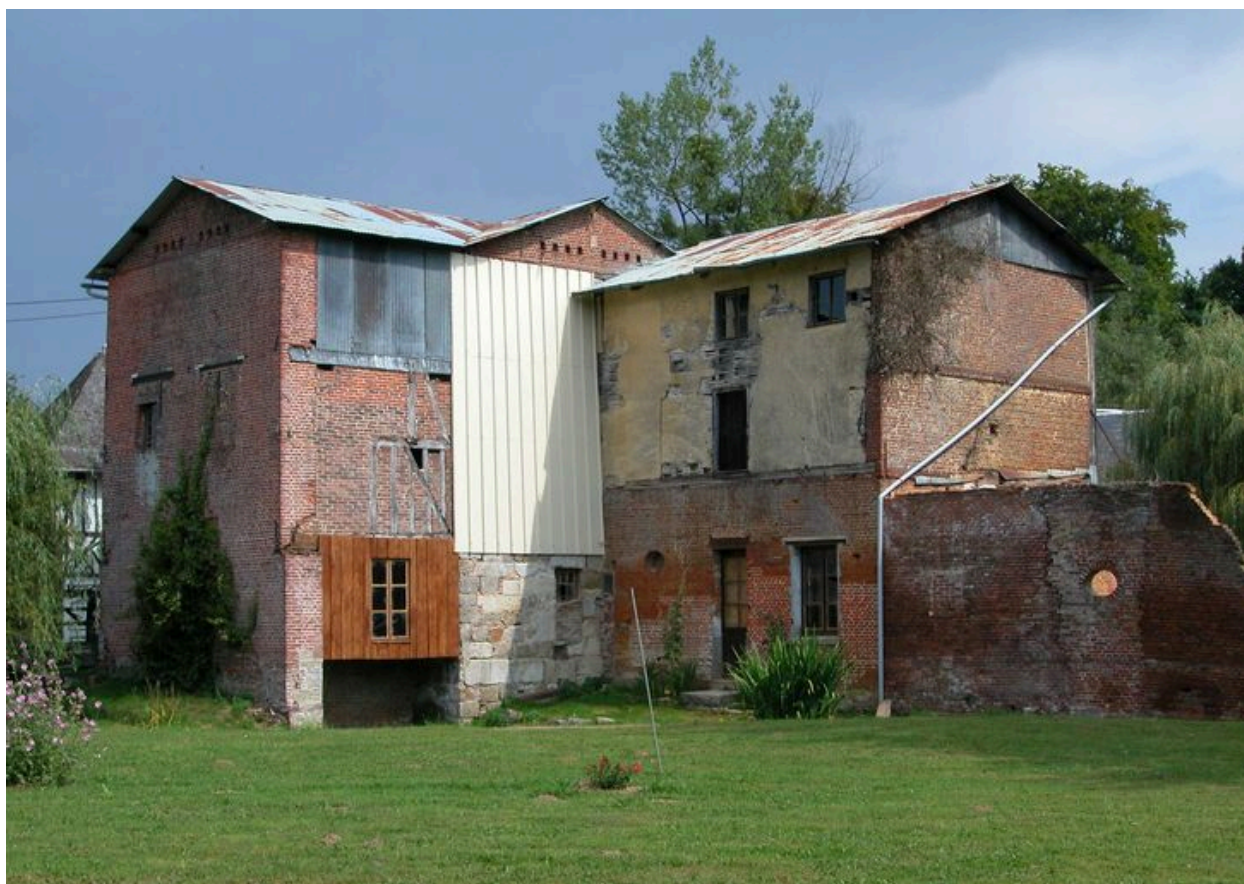
Vue d'ensemble sud du moulin.
