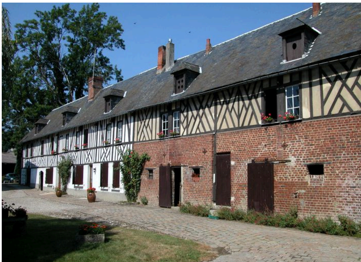
Vue d'ensemble du bâtiment d'habitation et des écuries, façade sur cour vue depuis l'ouest.
