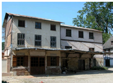
Façade sur cour du moulin. Phot. Bertrand Fournier IVR22_20036000542NUCA
