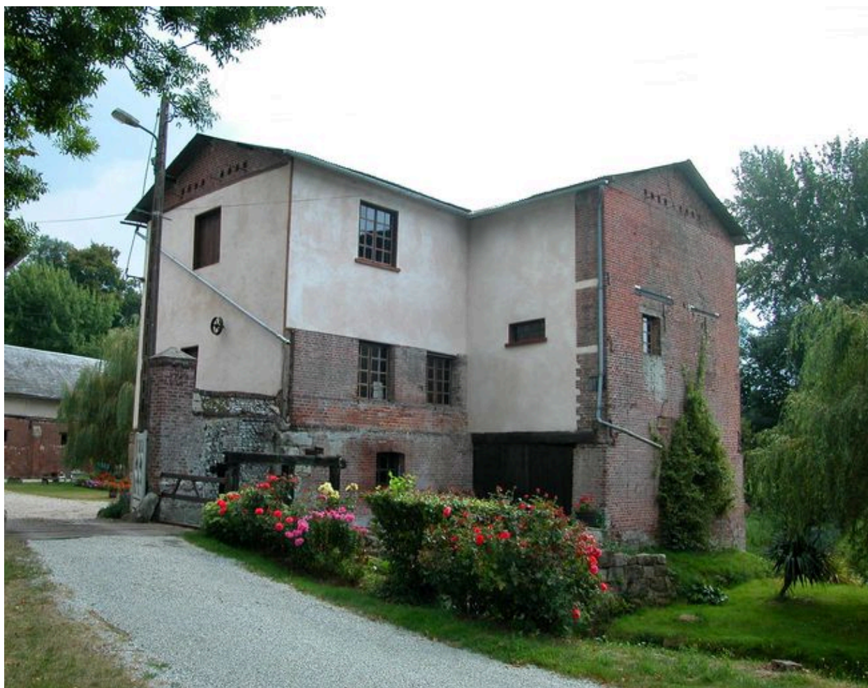
Ensemble occidental du moulin.
