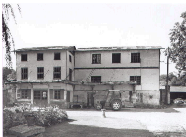
Façade sur cour du moulin. Phot. Thierry Lefébure IVR22_20026000930X
