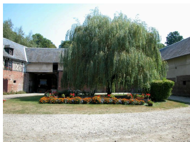
Façades sur cour des granges et dépendances agricoles du moulin. Phot. Bertrand Fournier IVR22_20036000545NUCA
