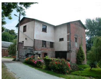
Ensemble occidental du moulin.
