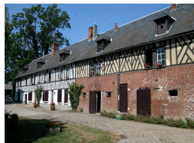
Vue d'ensemble du bâtiment d'habitation et des écuries, façade sur cour vue depuis l'ouest. Phot. Bertrand Fournier IVR22_20036000543NUCA
