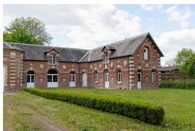
Partie nord des communs, vue depuis l'est. Phot. Marc Kérignard IVR32_20256000305NUCA
