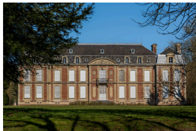
Vue générale depuis le portail. Phot. Marc Kérignard IVR32_20256000113NUCA
