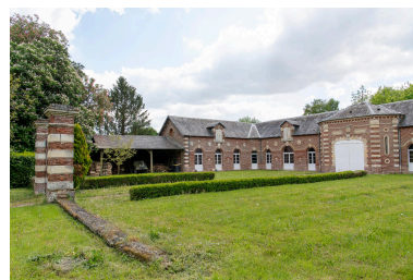
Partie sud des communs, vue depuis le nord. Phot. Marc Kérignard IVR32_20256000306NUCA
