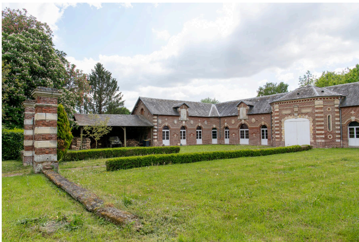
Partie sud des communs, vue depuis le nord.
