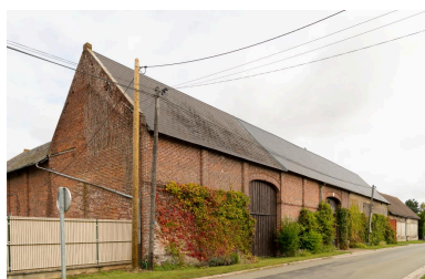
Vue des bâtiments agricoles alignés sur la rue depuis le sud-ouest. Phot. Marc Kérignard IVR32_20216001118NUCA
