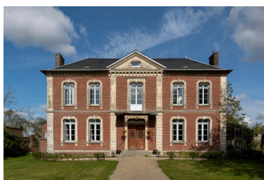
Vue générale du logis depuis le sud. Phot. Marc Kérignard IVR32_20216001184NUCA
