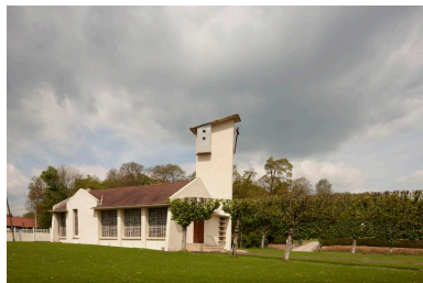
Vue générale latérale. Phot. Hubert Bouvet IVR31_20106200701NUCA
