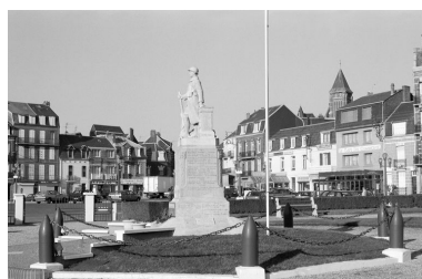
Vue de situation. Phot. Judith Förstel IVR22_19968000142Z
