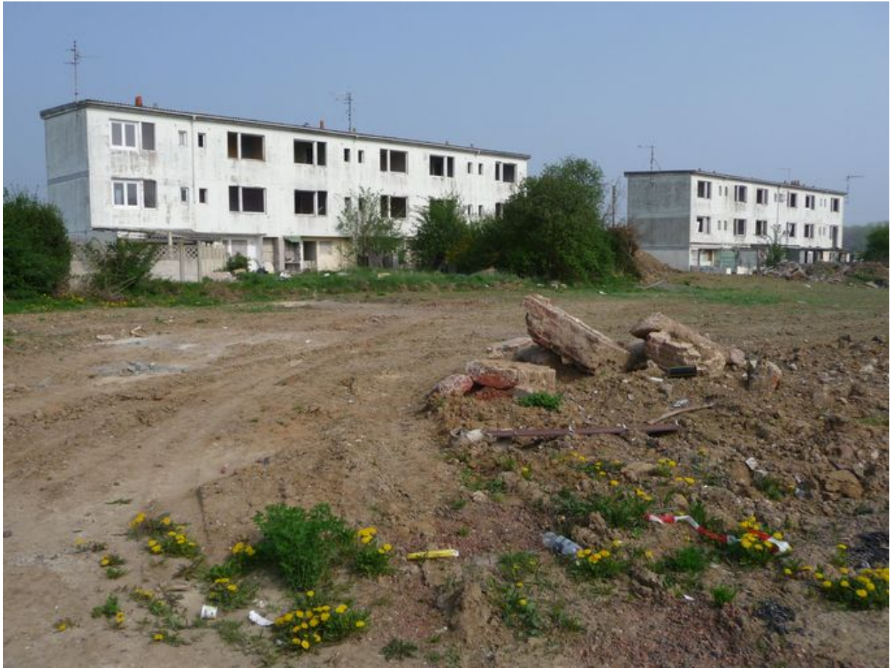
Vue générale de deux groupes de six logements.
