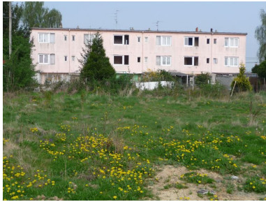
Groupe de six logements. Vue postérieure, côté jardin. Phot. Thierry Petitberghien IVR31_20106200318NUCA
