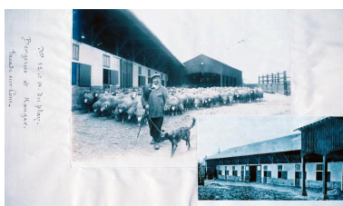
Bergerie et Hangar. Façade sur cour, avant 1914 (AD Somme ; 10 R 501).
