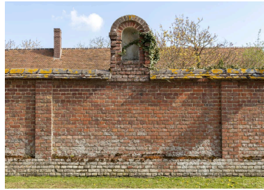
Mur en brique avec niche qui abritait une statue de saint Antoine avant 1970, partie est de la rue de Boursines, vue depuis le sud. Phot. Marc Kérignard IVR32_20216000268NUCA
