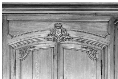
Porte à deux vantaux donnant sur la salle des pas perdus, linteau : détail. Phot. Jean-Michel Périn IVR31_19886200366X
