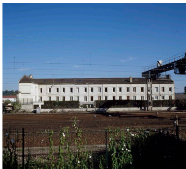
Façade antérieure des logements depuis le quai d'Aval. Phot. Thierry Lefébure IVR22_20106000675XA
