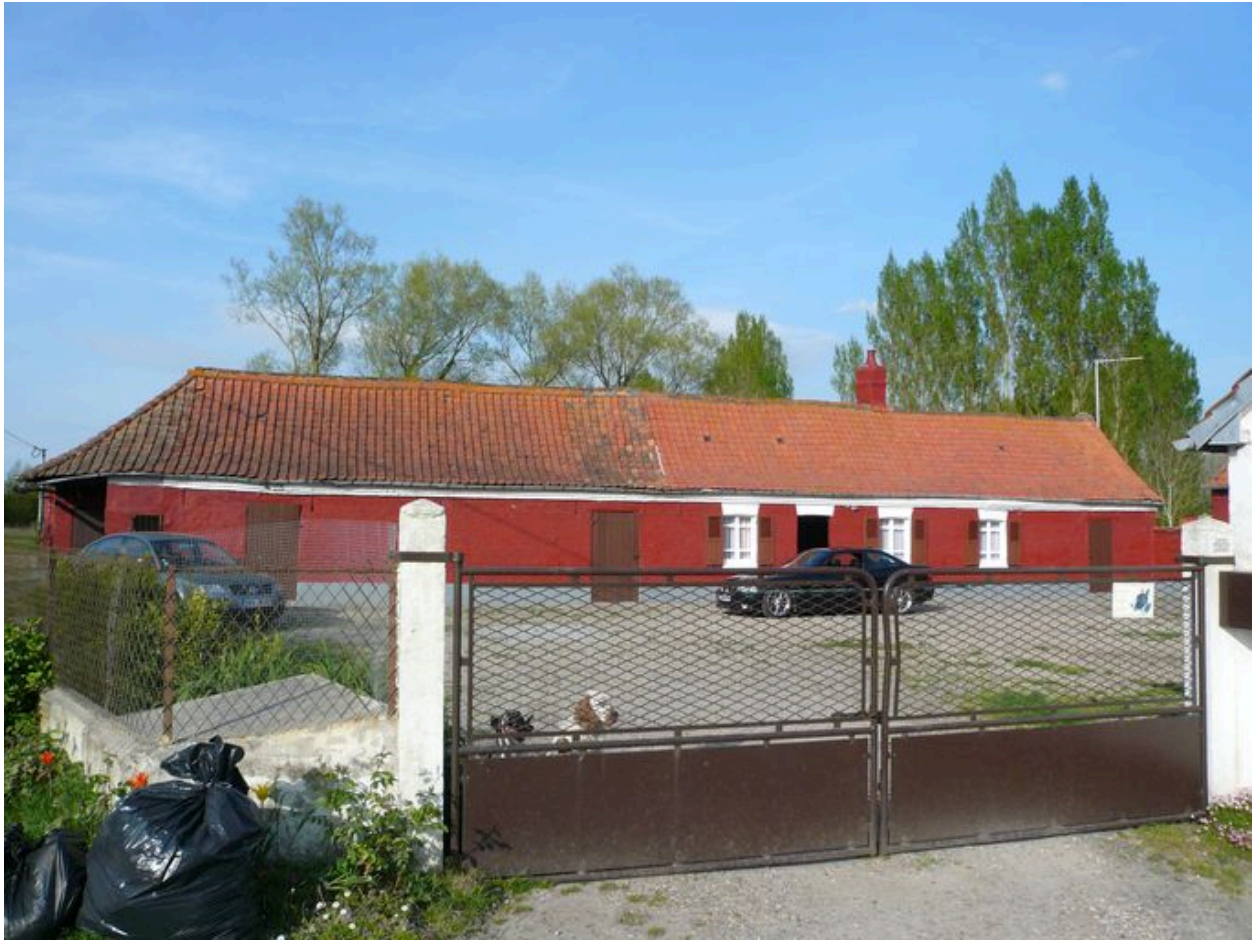
Vue du logis et de l'écurie dans son prolongement.
