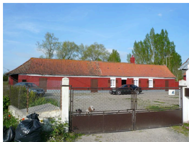
Vue du logis et de l'écurie dans son prolongement. Phot. Inès Guérin IVR22_20078005923NUCA
