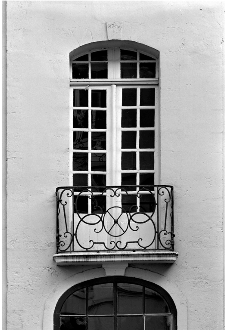
Garde corps du logis en fond de cour.
