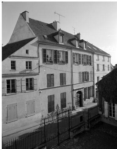
Elévation sur la rue. Phot. Thierry Lefébure IVR22_19940201183V
