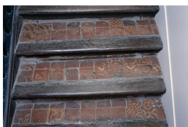
Carreaux vernissés réemployés dans l'escalier du logis principal. Phot. Thierry Lefébure IVR22_19940201174XA
