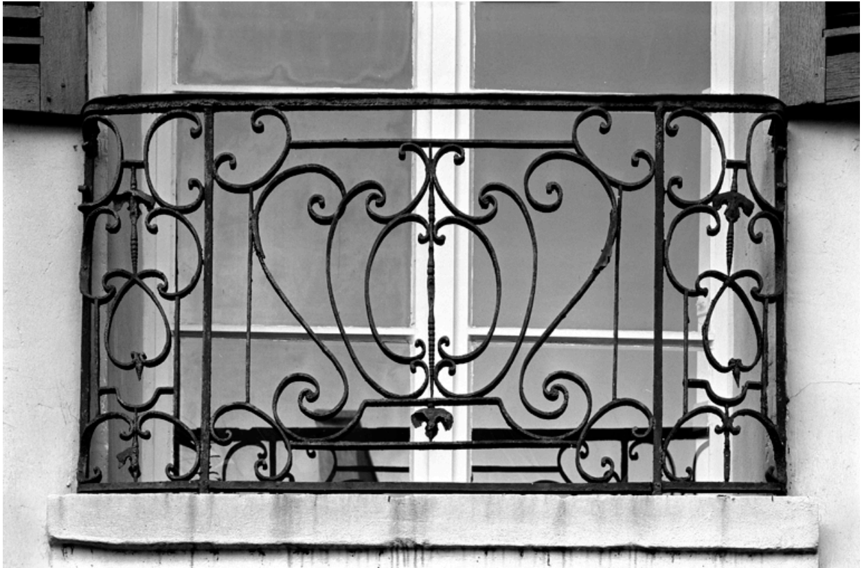
Garde corps d'une fenêtre sur cour du logis principal.
