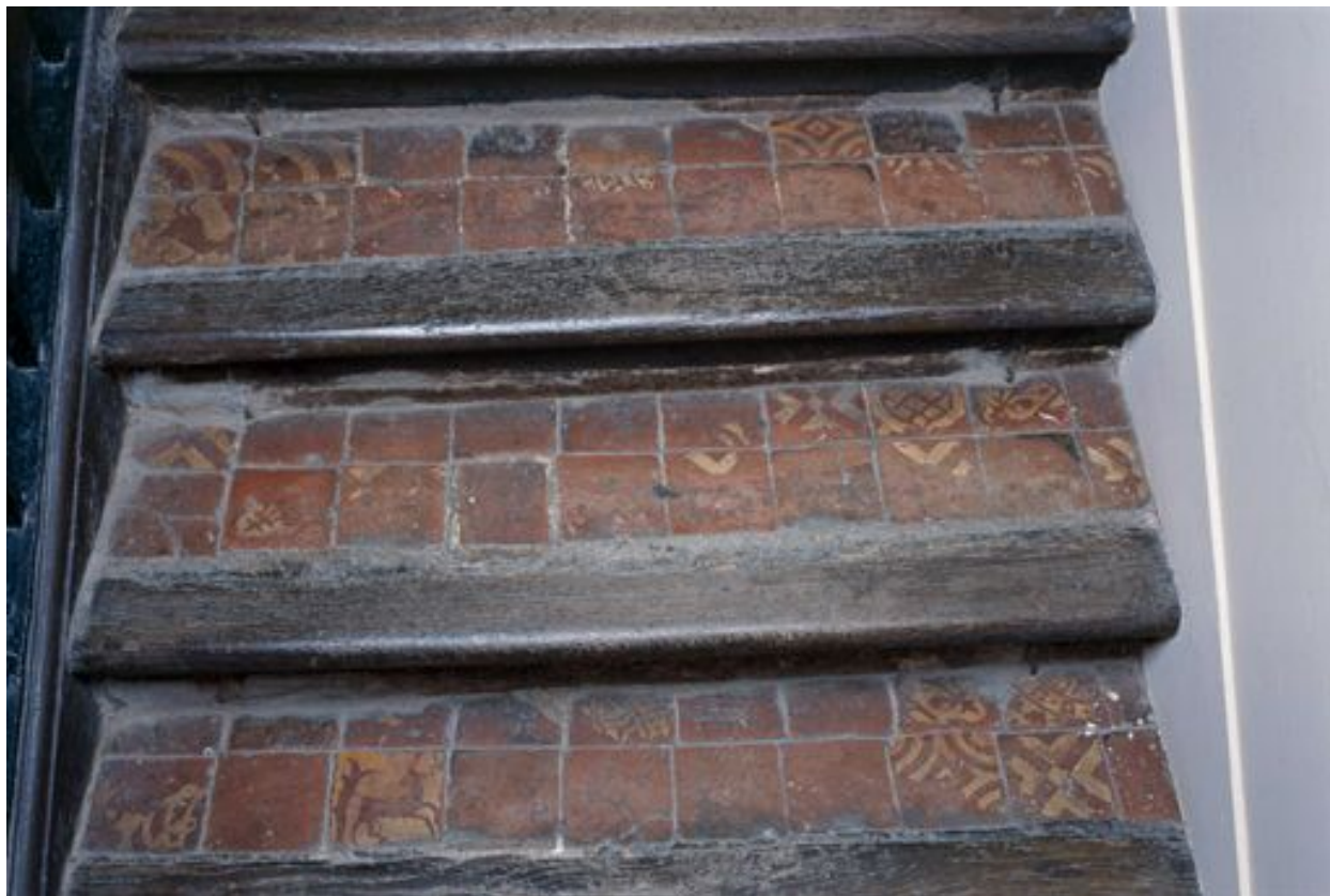
Carreaux vernissés réemployés dans l'escalier du logis principal.
