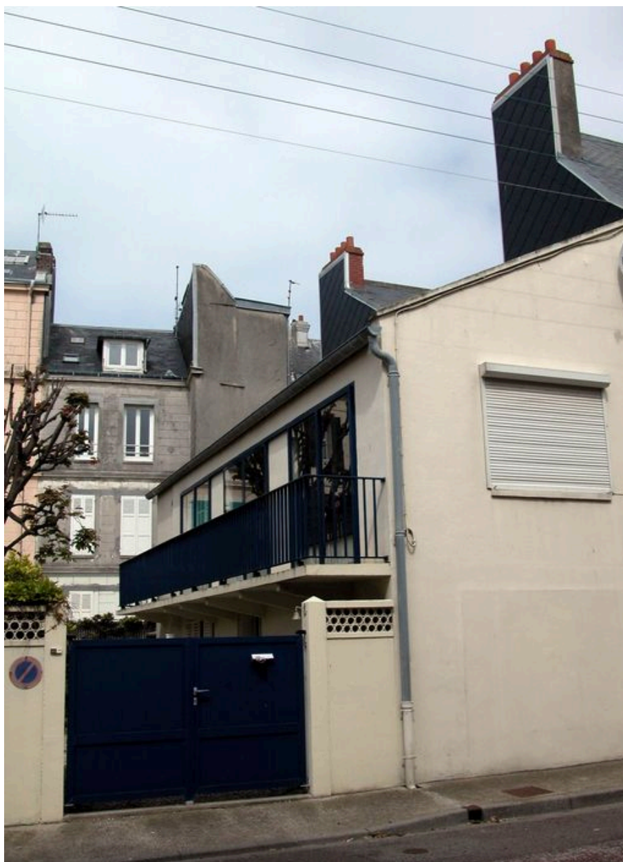
Aménagements tardifs, 24 rue Henri-Leboeuf (1982 AH 957).
