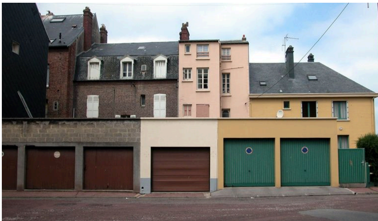
Ensemble de garages, 6 à 10 rue Henri-Leboeuf.
