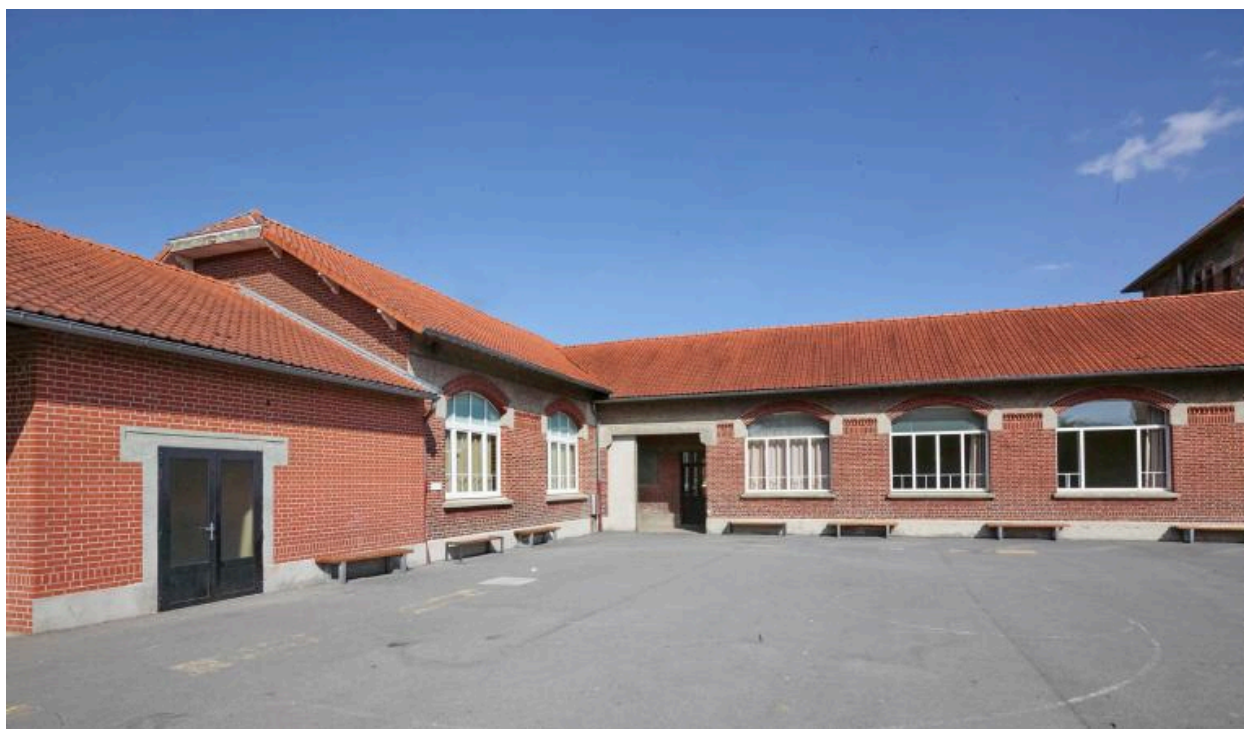
Ecole Carlin, vue des bâtiments sur cour.
