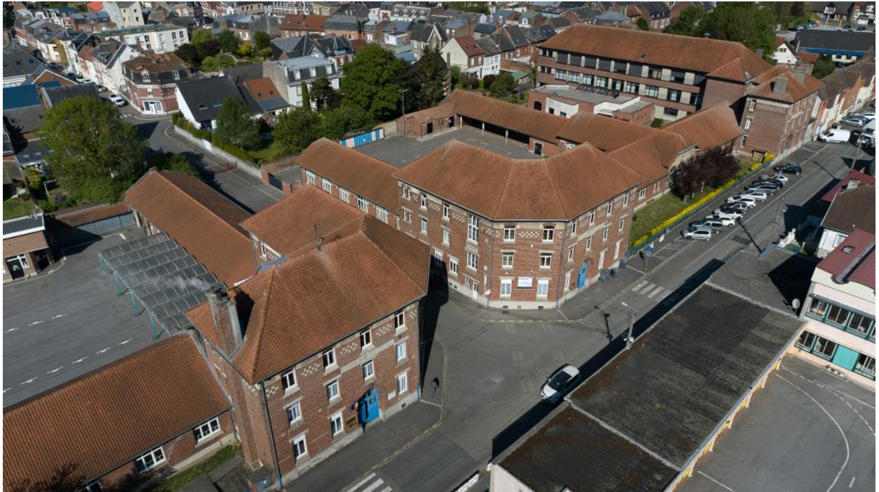
Vue générale aérienne de l'école, avec les façades longeant le boulevard des écoles.
