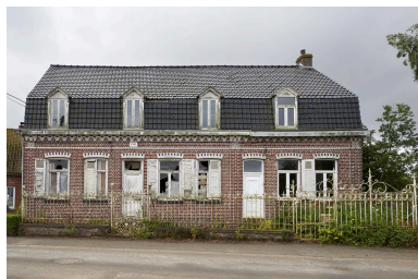
Façade sur rue. Phot. Delphine Volto Jourdan IVR32_20245902696NUCA
