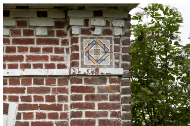
Détail décoratif, carreau de faïence inséré dans la maçonnerie. Phot. Delphine Volto Jourdan IVR32_20245902695NUCA
