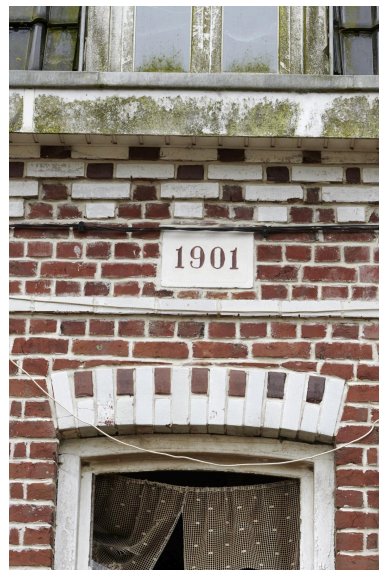
Détail de la date portée "1901" et motifs décoratifs en brique. Phot. Delphine Volto Jourdan IVR32_20245902694NUCA
