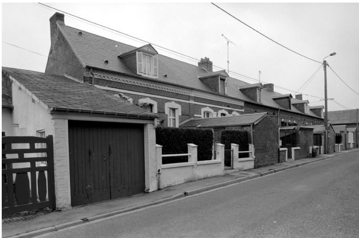
Logements d'ouvriers (rue Curie), vue générale, en 1991.
