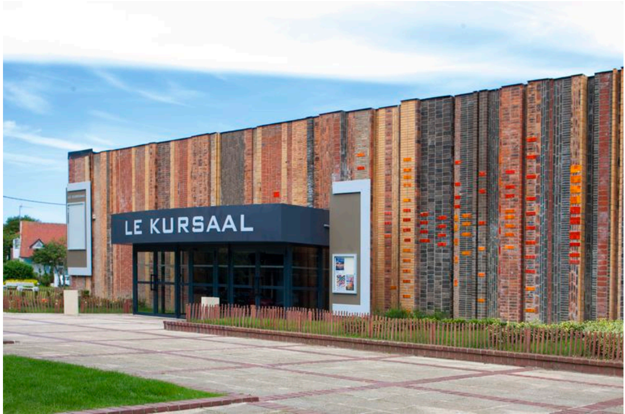
Vue de trois quarts de l'entrée.
