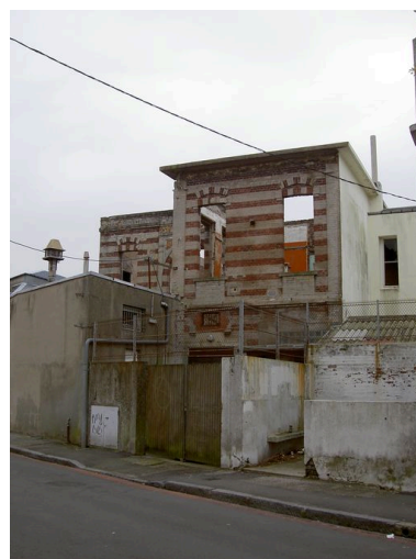
Vue partielle arrière, depuis la rue des Lyons. Phot. Sophie Luchier IVR31_20066200606NUCA
