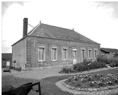
Vue générale de l'élévation postérieure du logis. Phot. Laurent Jumel IVR22_19980201767X
