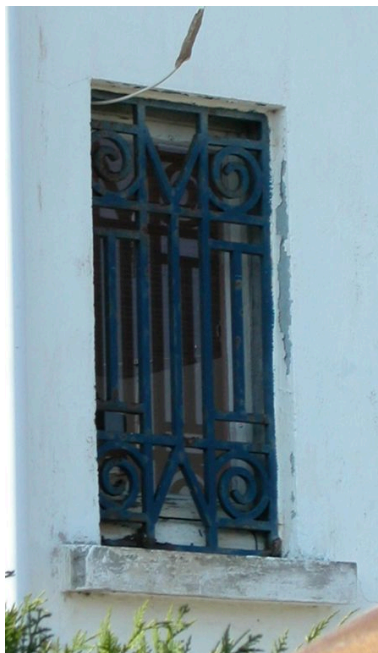
Détail d'une grille protégeant une baie de la façade latérale droite. Phot. Elisabeth Justome IVR22_20058002797NUCA
