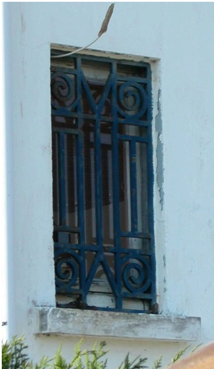
Détail d'une grille protégeant une baie de la façade latérale droite.
