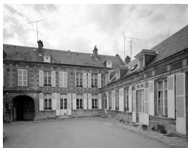
Élévation sur cour. Phot. Fabrice Charrondièrre IVR22_19856001477V
