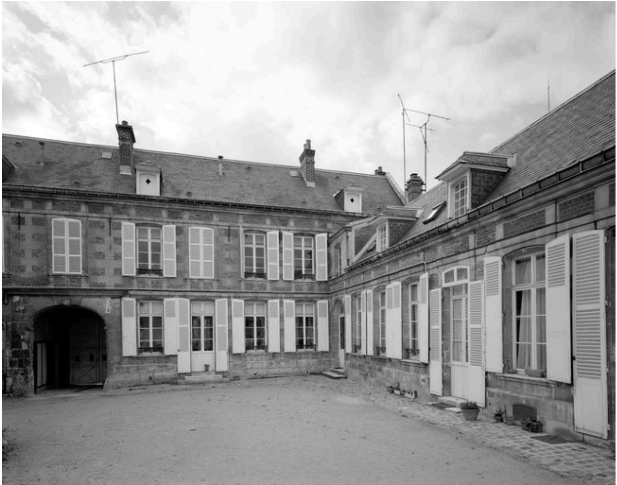
Elévation sur cour.
