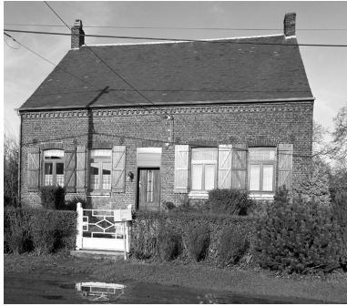
Vue générale. Phot. Thierry Lefébure IVR22_19960200933X
