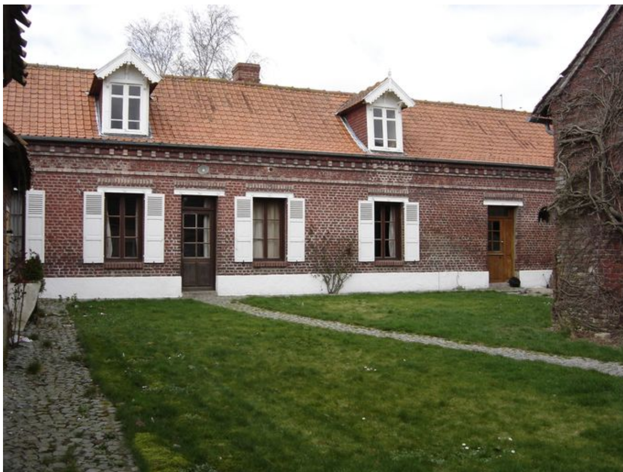
Vue du logis depuis la rue.
