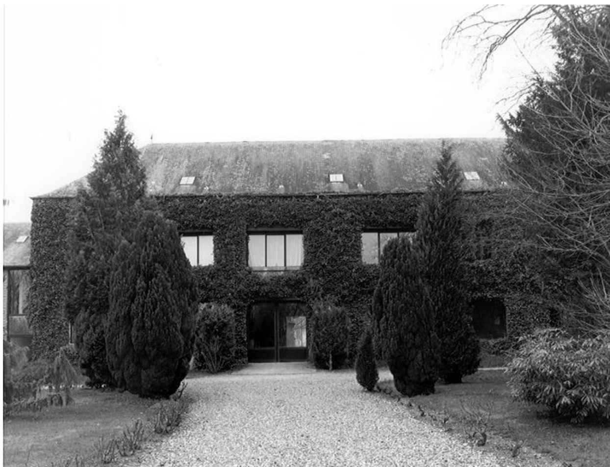
Vue d'ensemble de la façade sur cour.
