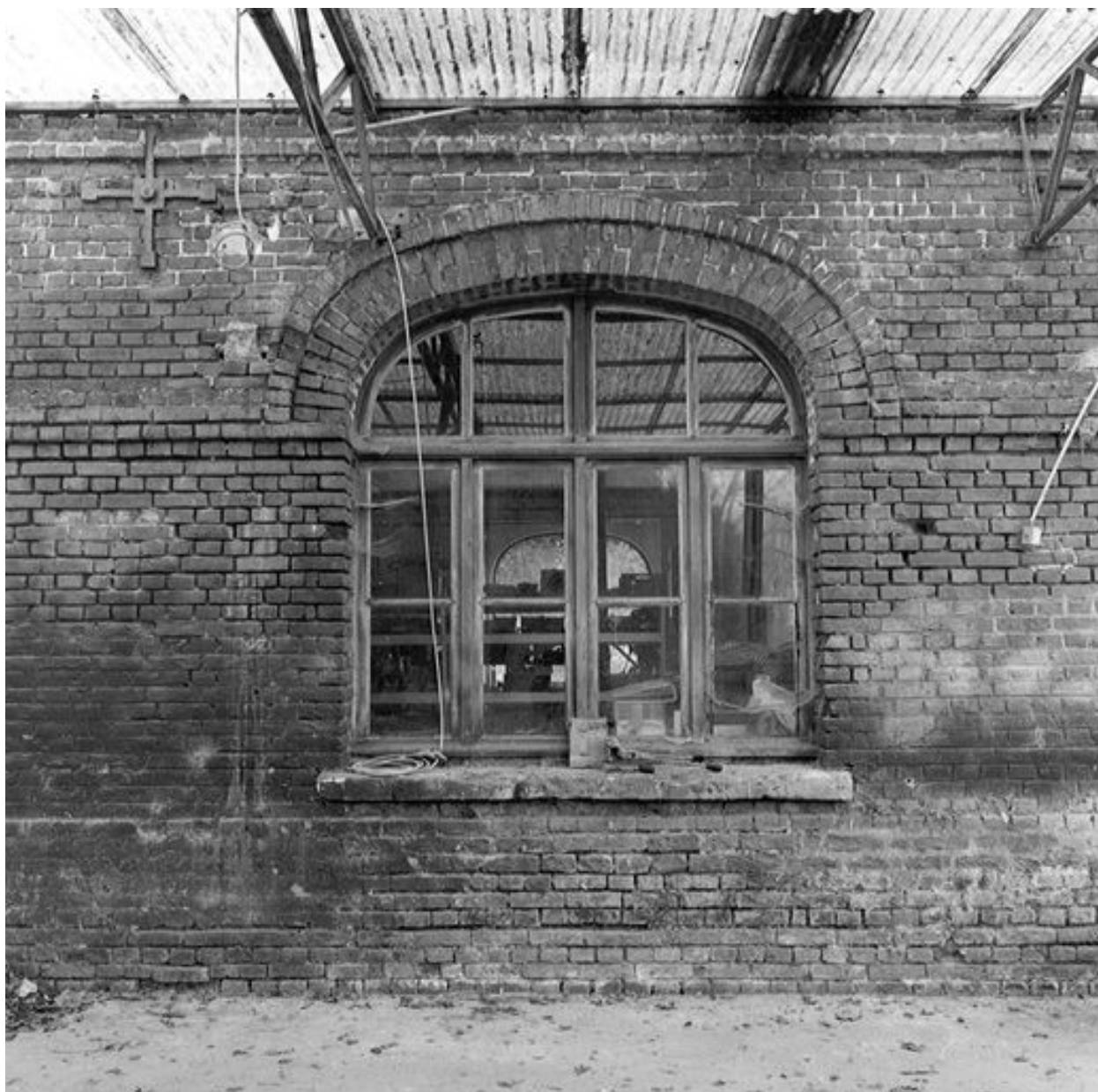
Détail d'une des ouvertures d'origine.
