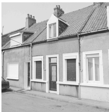
Façade sur voie. Phot. Philippe Dapvri IVR31_19946200570X
