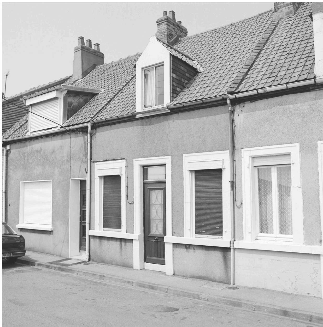
Façade sur voie.
