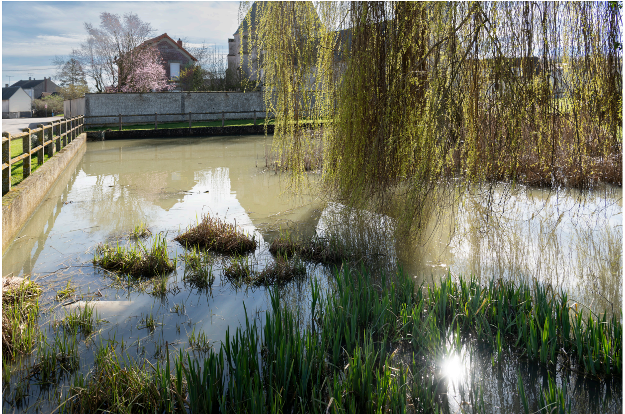
Mare près de l'église, rue Martin, vue prise depuis l'ouest.
