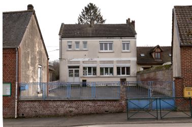
École, vue prise depuis le nord. Phot. Marc Kérignard IVR32_20246000124NUCA
