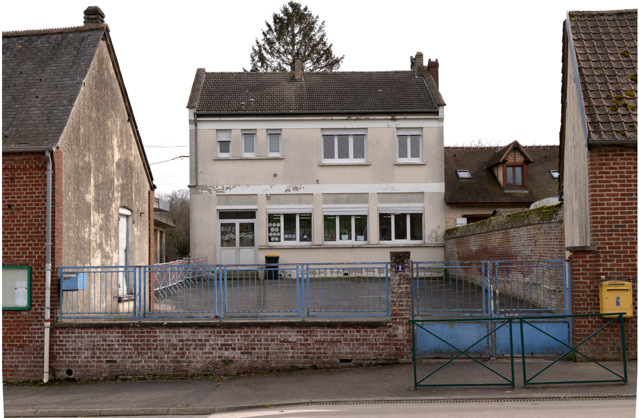
École, vue prise depuis le nord.
