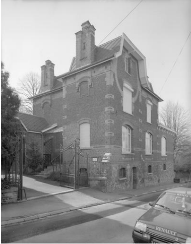
Élévation de trois quarts. Phot. Olivier Marlard IVR31_19935900468V
