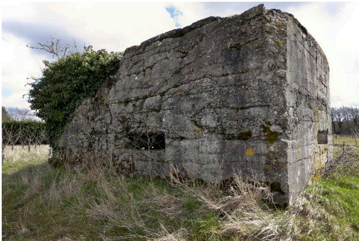
Vue vers le sud-est
