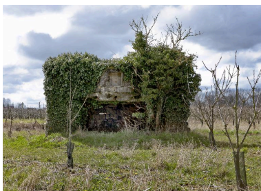
Elévation antérieure, vers l'ouest Phot. Jean-Marc Ramette
