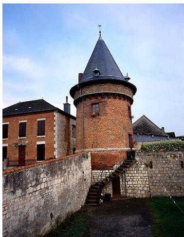
Tour de Chimay. Phot. Thierry Lefébure IVR22_19990205456VA
