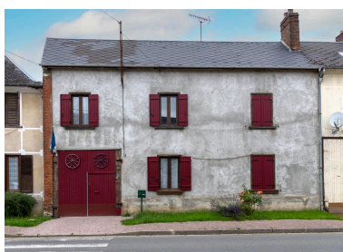
Logis sur rue avec entrée charretière, n°22 rue Principale, vue depuis l'est.
