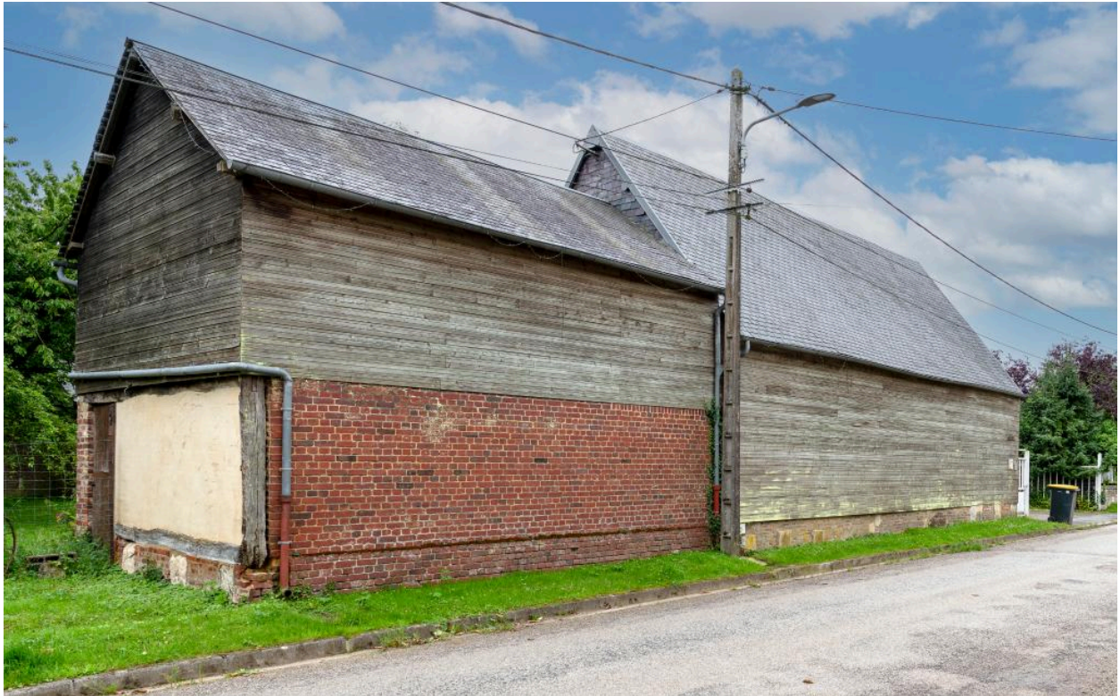
Bâtiments agricoles essentés en clins de bois, n°5 rue de Doméliers, vue depuis le nord-est.
