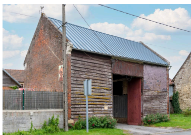
Grange au n°51 rue Principale, vue depuis l'ouest. Phot. Marc Kérignard IVR32_20216000858NUCA
