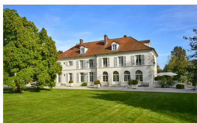
Château de Cocquerel, depuis l'ouest. Phot. Thierry Lefébure IVR32_20238000636NUCA
