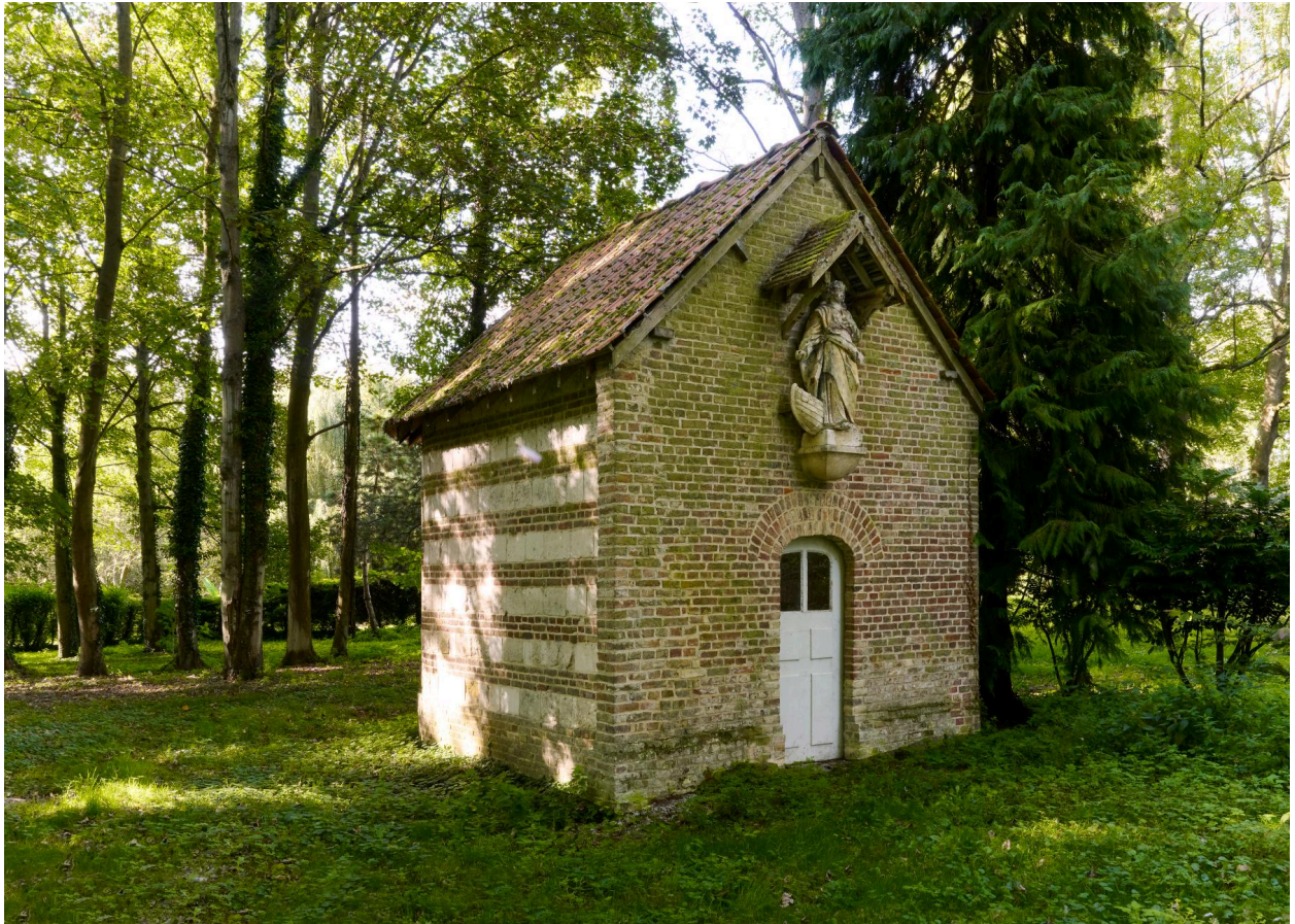
Vue d'ensemble de la chapelle, depuis l'est.
