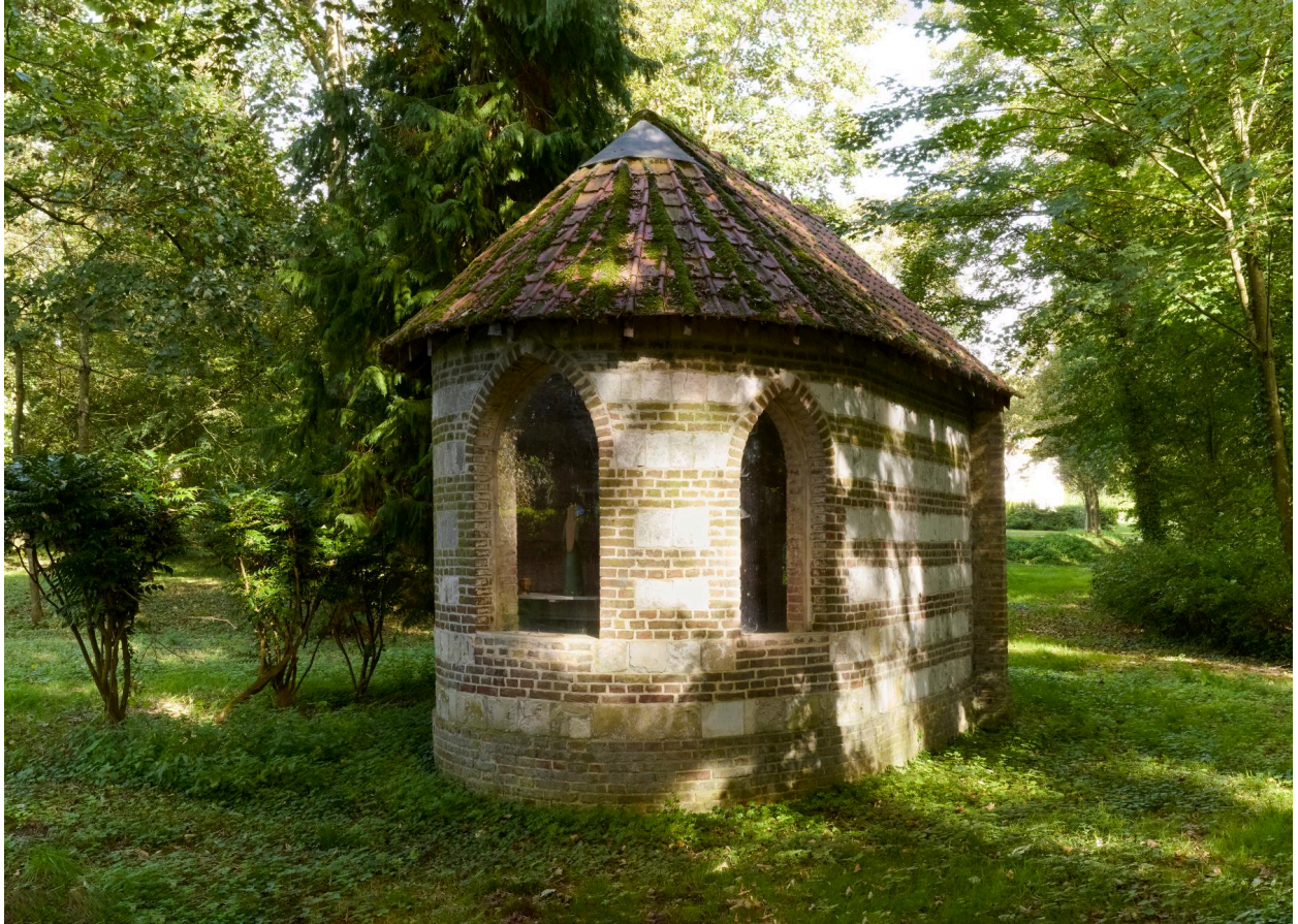
Vue du chevet, depuis le sud.
