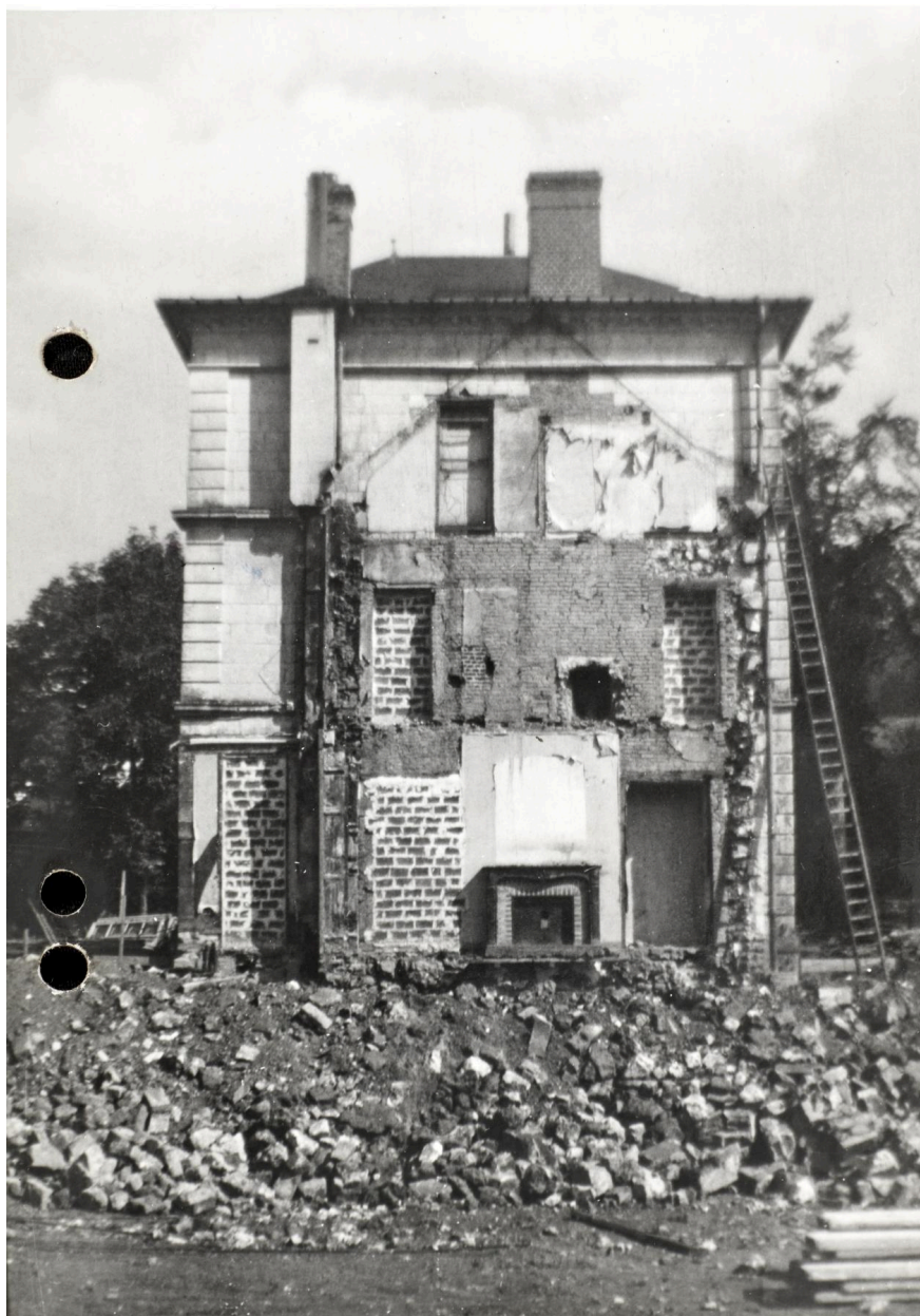
Château de Cocquerel, reconstruction, photographie prise par l'entreprise générale Léon Grosse, 7 septembre 1950 (AD Somme ; 7 W 116).
