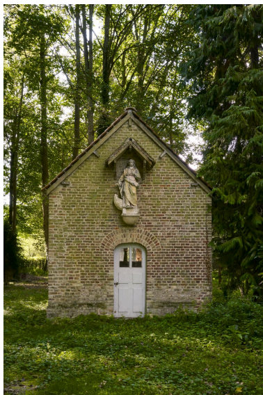
Façade nord-est de la chapelle. Phot. Thierry Lefébure IVR32_20238000644NUCA
