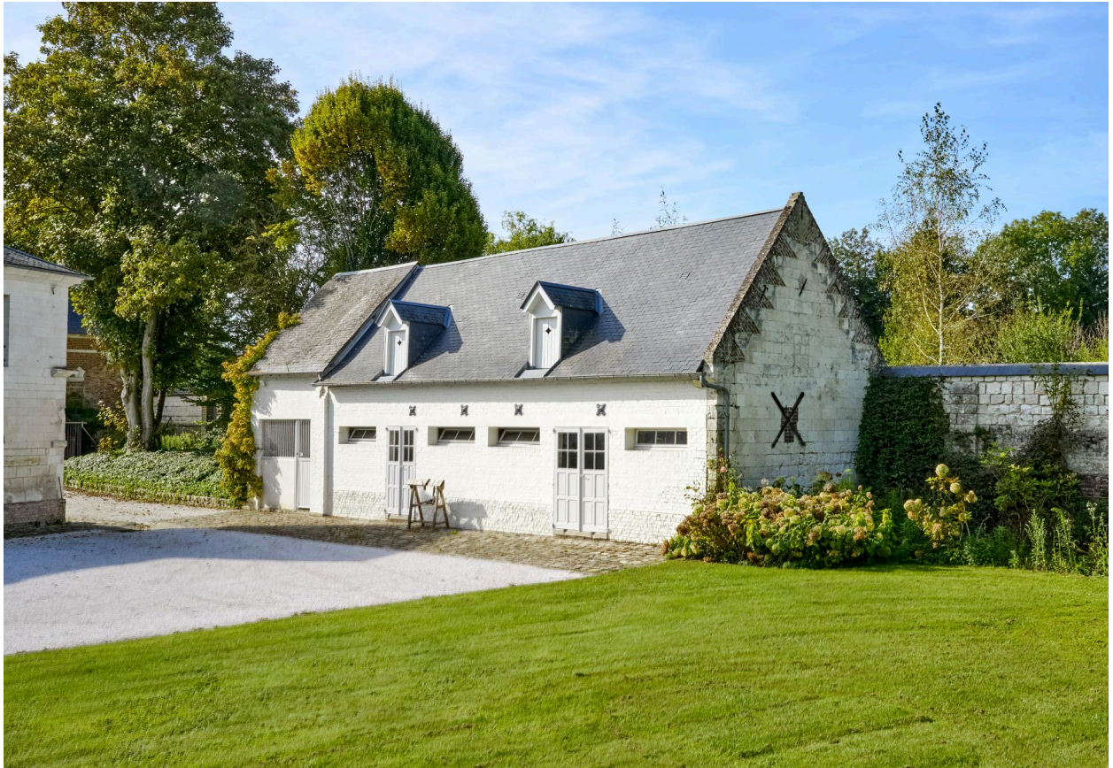
Vue de la seconde dépendance, depuis le sud-est.
