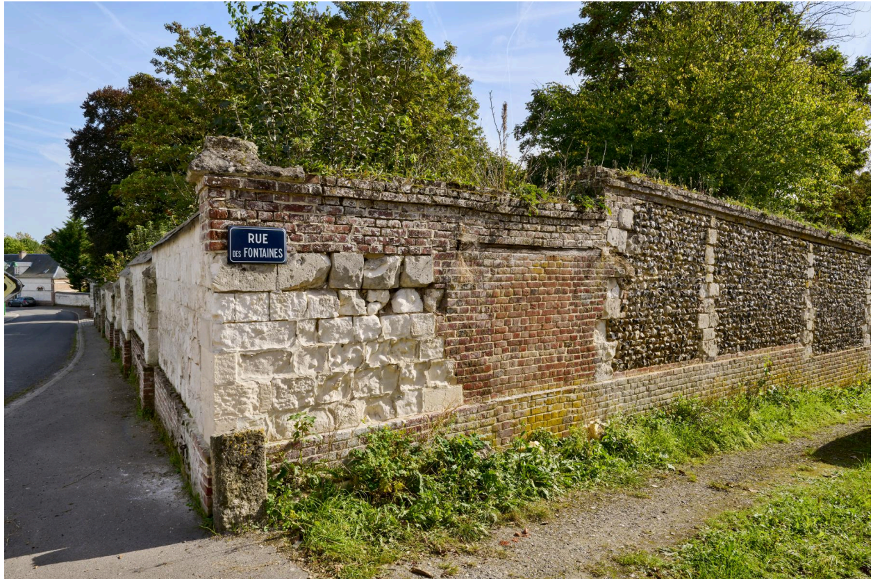
Détail du mur de délimitation du parc du château, depuis l'ouest.
