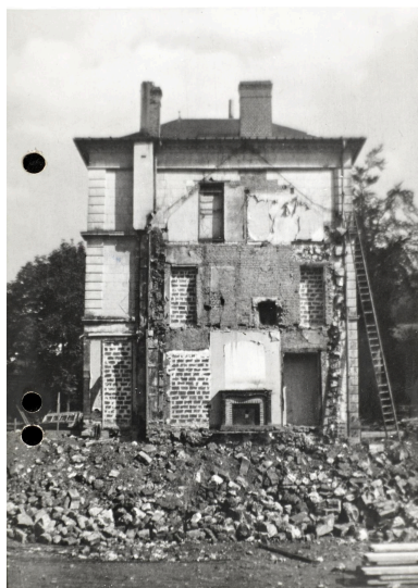
Château de Cocquerel, reconstruction, photographie prise par l'entreprise générale Léon Grosse, 7 septembre 1950 (AD Somme ; 7 W 116). Repro. Thierry Lefébure IVR32_20248000068NUCA
