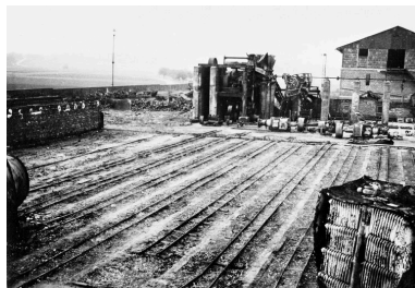
REMY. Briqueterie Bohy. Vestiges des rails de séchage des briques après l'incendie du 19 septembre 1934 (AP). Phot. Thierry Lefébure IVR22_20006000208XB
