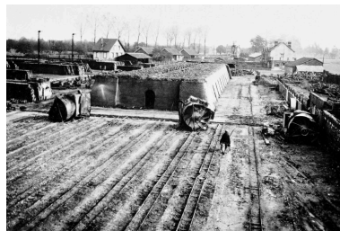
REMY. Briqueterie Bohy. Vestiges des rails de séchage des briques et du four, après l'incendie du 19 septembre 1934 (AP). Phot. Thierry Lefébure IVR22_20006000209XB
