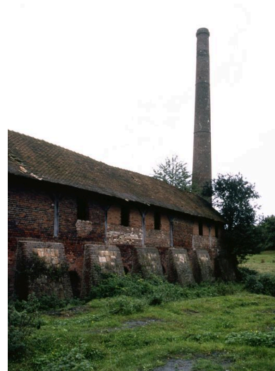
REMY. Vue d'ensemble de la briqueterie Dupuis. Phot. Benoît Dufournier IVR22_19876000366ZA
