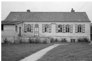
Elévation antérieure. Phot. Jean-Michel Perrin IVR22_19846001060X
