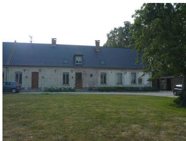
Vue détaillée de la façade du logis au nord. Phot. Inès Guérin IVR22_20078005892NUCA
