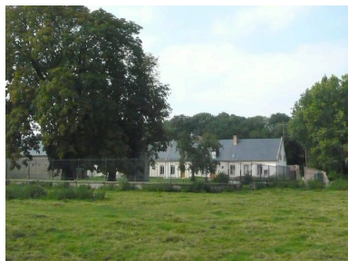
Vue générale. Phot. Inès Guérin IVR22_20078005891NUCA
