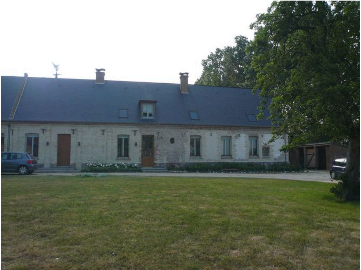
Vue détaillée de la façade du logis au nord.
