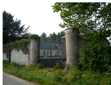
Vue de l'entrée au sud de la cour. Phot. Inès Guérin
