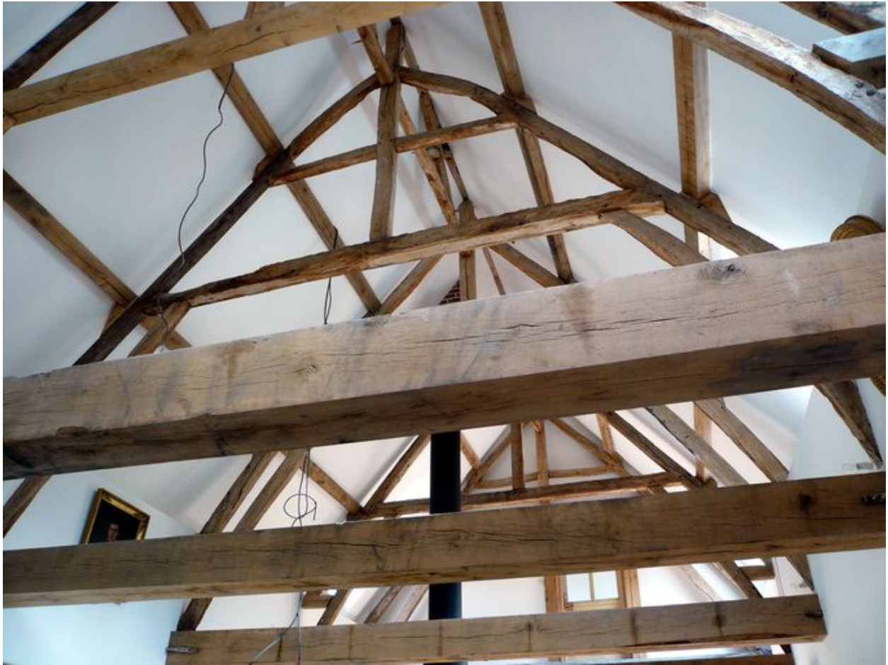
Vue d'une partie de la charpente du logis.
