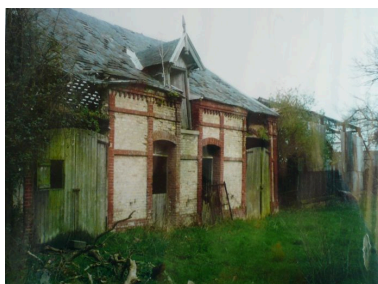
Vue des étables à l'origine situées au nord de la cour, aujourd'hui détruites.
