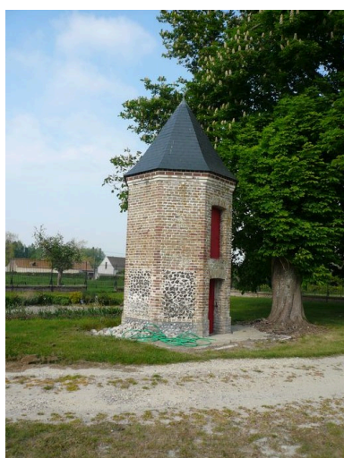
Vue du pigeonnier. Phot. Inès Guérin IVR22_20078005897NUCA
