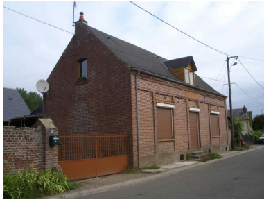
Vue générale. Phot. Inès Guérin IVR22_20078005135NUCA
