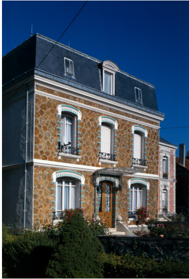
Elévation sur la rue. Phot. Thierry Lefébure IVR22_19940201171XA
