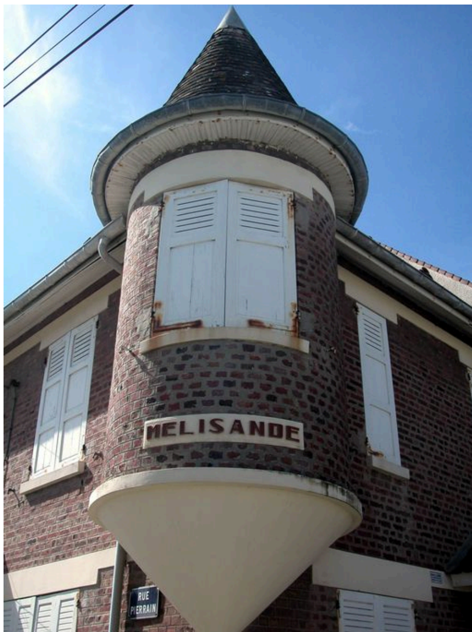
Détail de la tourelle d'angle en surplomb.
