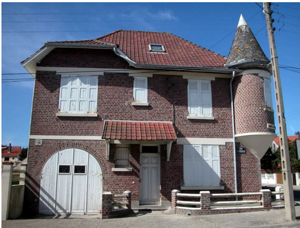
Elévation latérale, rue Pierrain.
