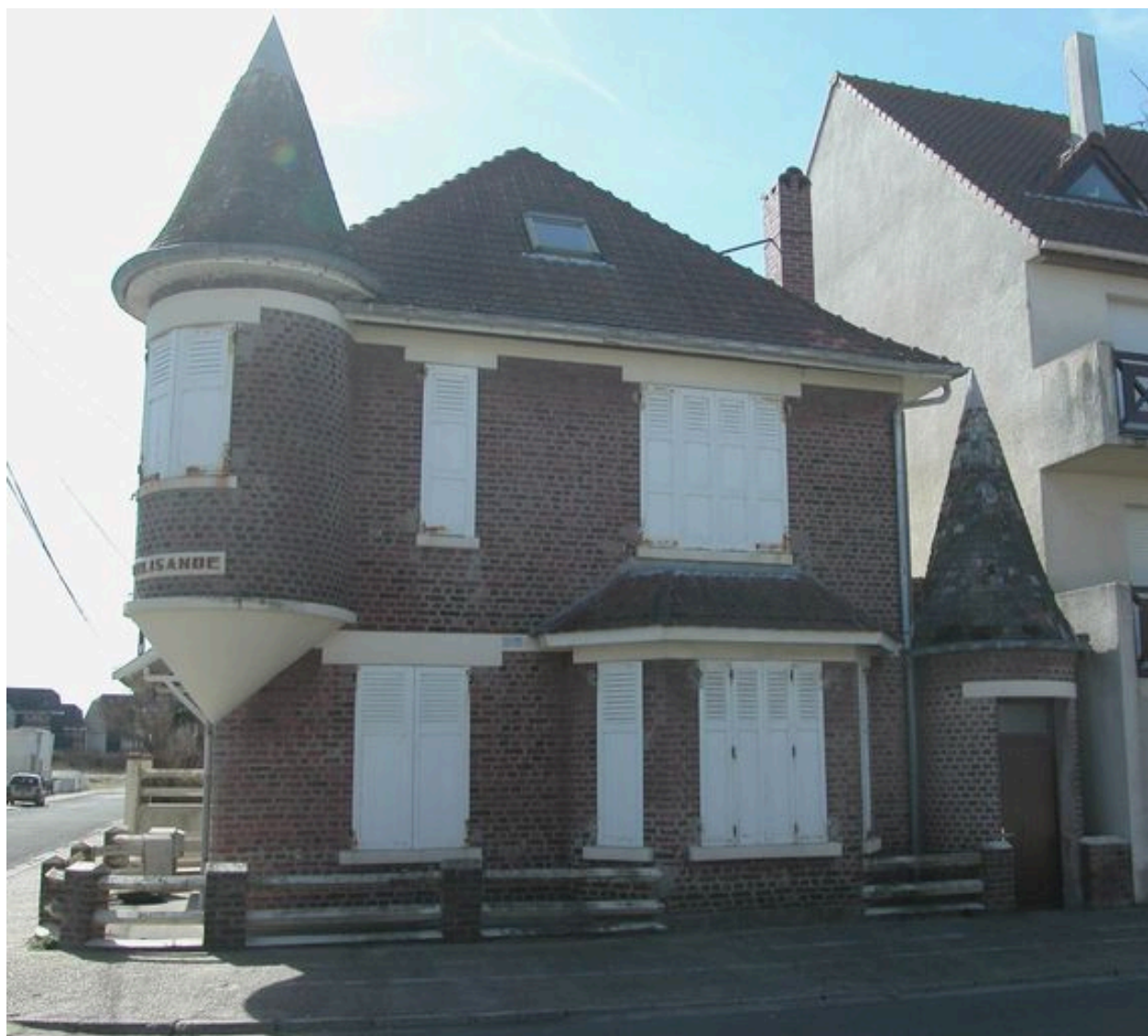
Elévation antérieure, rue de l'Amiral-Courbet.
