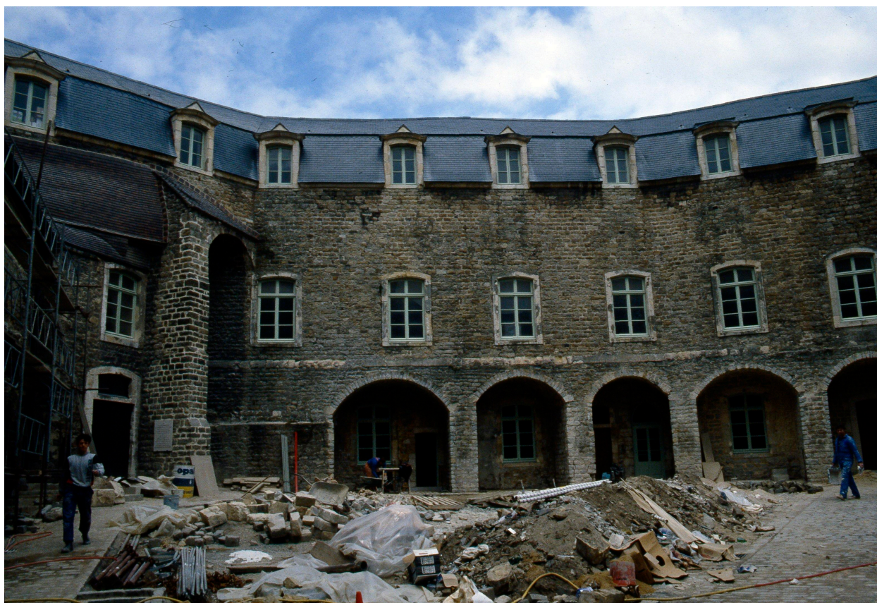
Sur cour d'honneur, façade ouest en cours de restauration (17 juin 1988).
