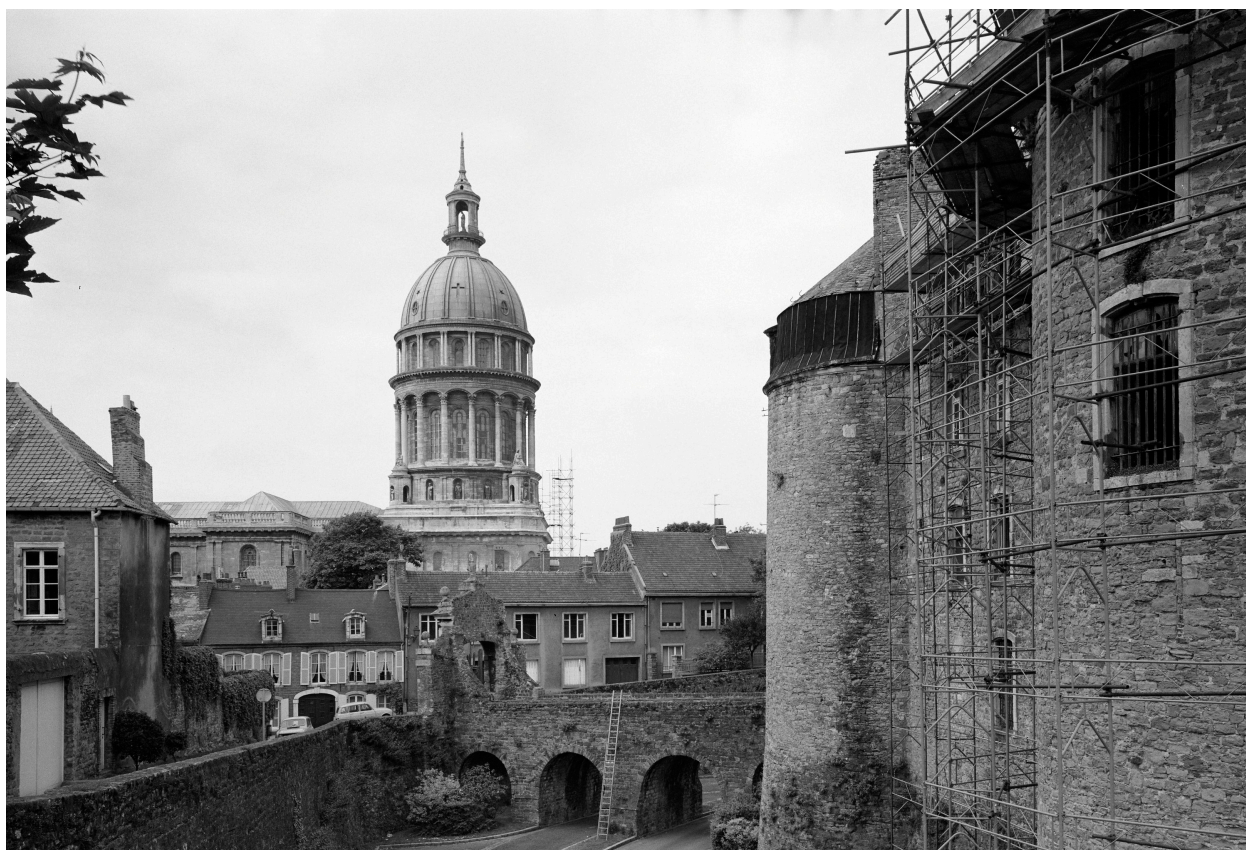
Façade sud-ouest, vue de profil, pont, en cours de restauration.
