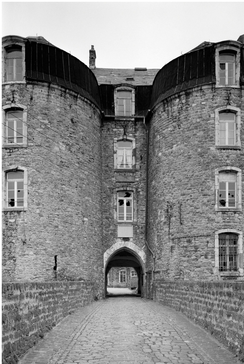
Façade sur pont en cours de restauration.
