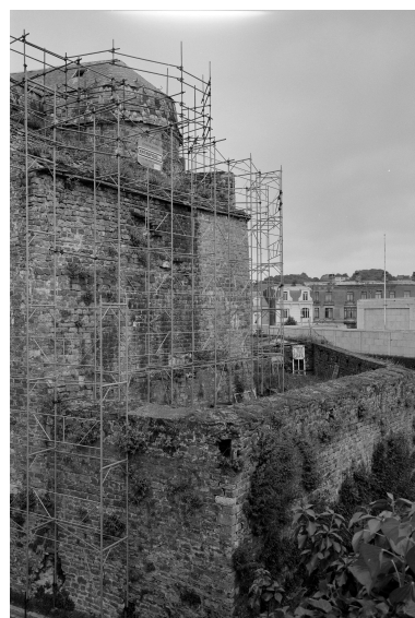
Façade sud partielle en cours de restauration. Phot. Jean-Michel Périn, Phot. Éric Dessert IVR31_19806202987X
