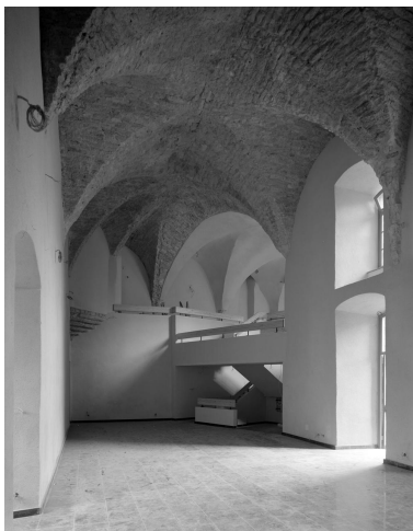
Chapelle, vue générale de l'entrée de la salle comtale en cours de restauration.
