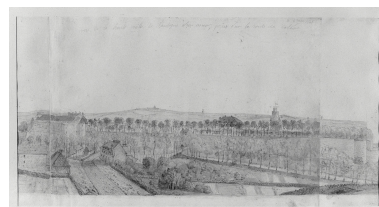
Vue générale en 1821, dessin Meuniez, collection privée. Phot. Philippe Caudroit IVR31_19806200475X
