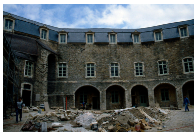
Sur cour d'honneur, façade ouest en cours de restauration (17 juin 1988). Phot. Jean-Michel Périn IVR31_19886201815ZA
