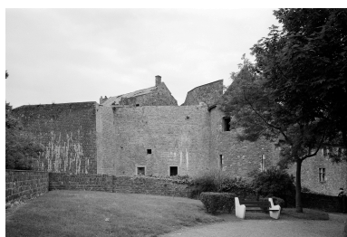
Vue du rempart de la façade nord. Phot. Jean-Michel Périn IVR31_19806203051X
