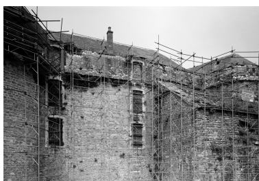
Façade sud, toiture en cours de restauration. Phot. Jean-Michel Périn, Phot. Éric Dessert IVR31_19876202990X
