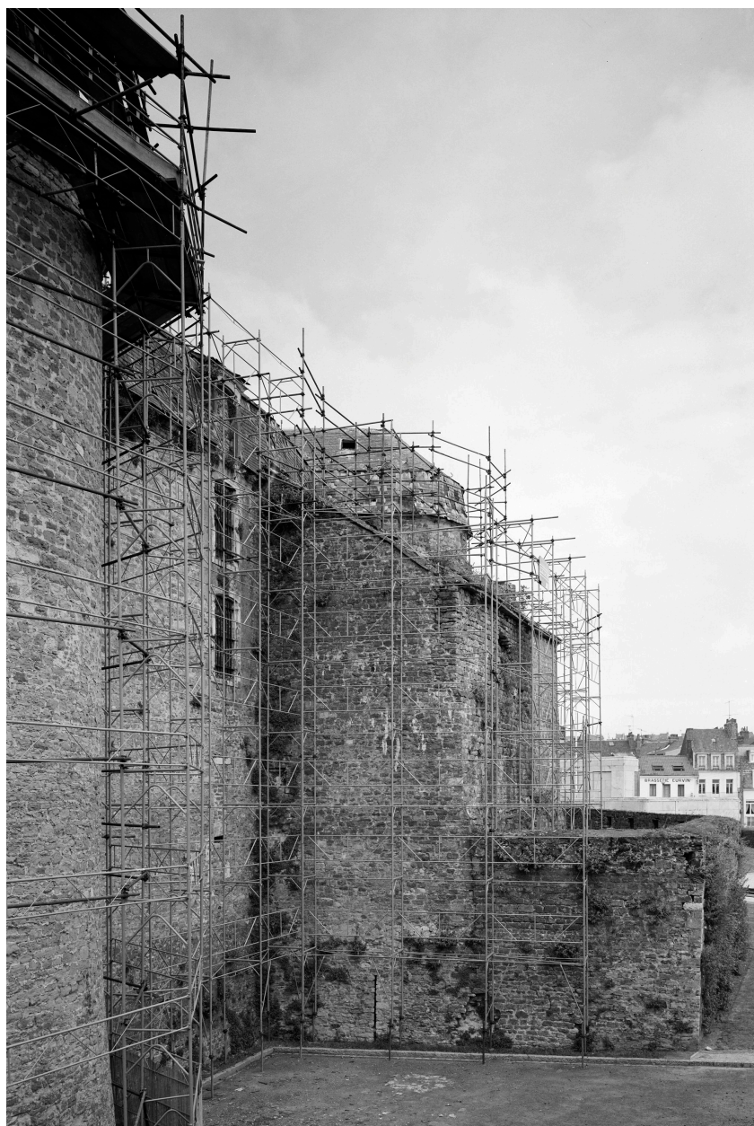
Façade sud, vue de profil en cours de restauration.
