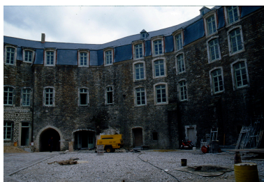
Sur cour d'honneur, façade nord en cours de restauration. Phot. Jean-Michel Périn IVR31_19886201817ZA
