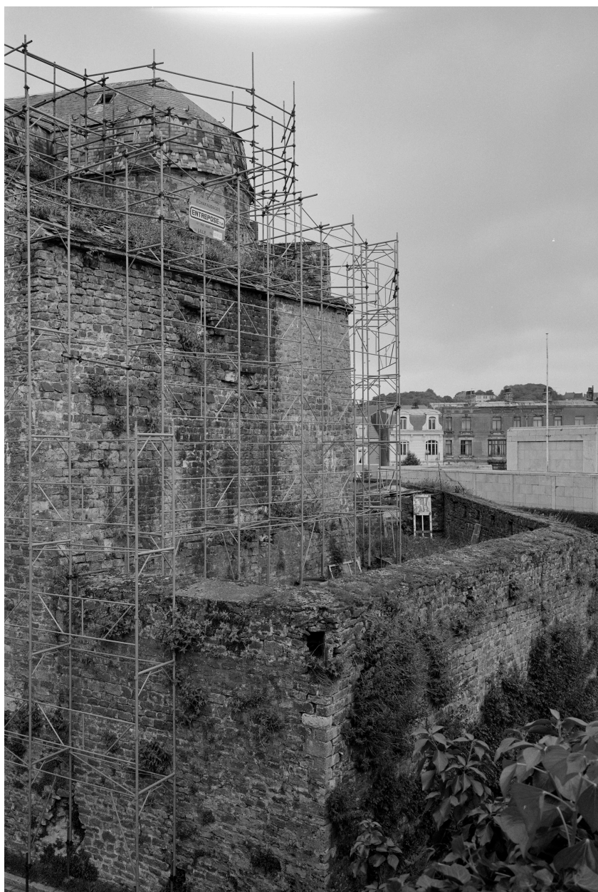
Façade sud partielle en cours de restauration.
