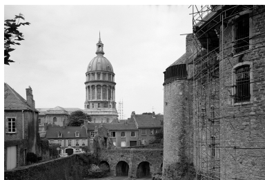
Façade sud-ouest, vue de profil, pont, en cours de restauration. Phot. Jean-Michel Périn, Phot. Éric Dessert IVR31_19806202989X
