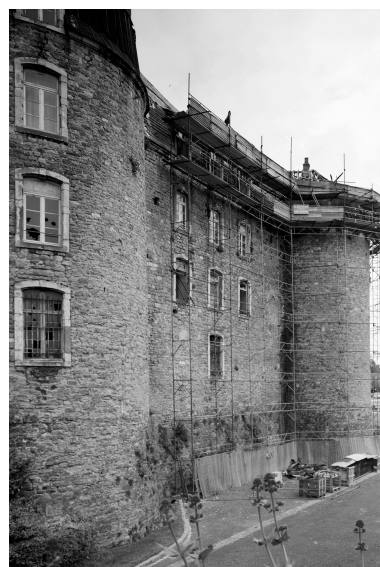
Façade sud-ouest en cours de restauration. Phot. Éric Dessert, Phot. Jean-Michel Périn IVR31_19806202442X
