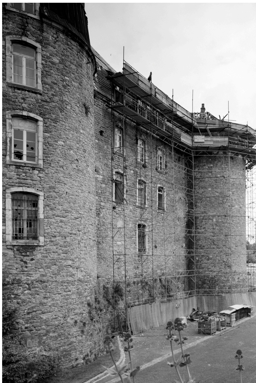
Façade sud-ouest en cours de restauration.
