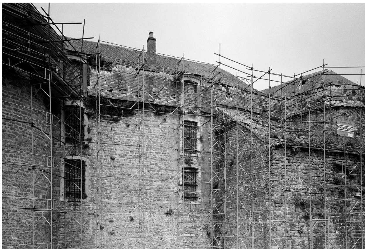
Façade sud, toiture en cours de restauration.
