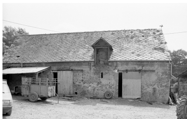
Elévation sur cour de l'étable sud-est. Phot. Thierry Lefébure IVR22_19920201338Z
