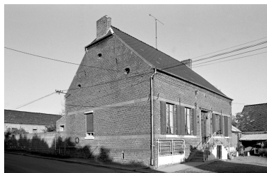
Vue d'ensemble ouest du logis édifié en 1861. Phot. Christiane Riboulleau IVR22_19900202525Z
