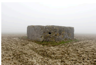
Vue de trois-quarts vers le nord-est Phot. Pierre Thibaut IVR31_20145905452NUCA
