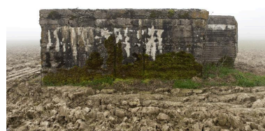
Elévation nord-est Phot. Jean-Marc Ramette IVR31_20145905456NUCA
