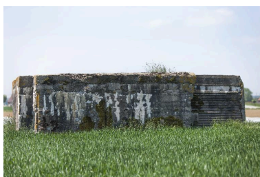
Elévation nord-est Phot. Jean-Marc Ramette IVR31_20145905460NUCA
