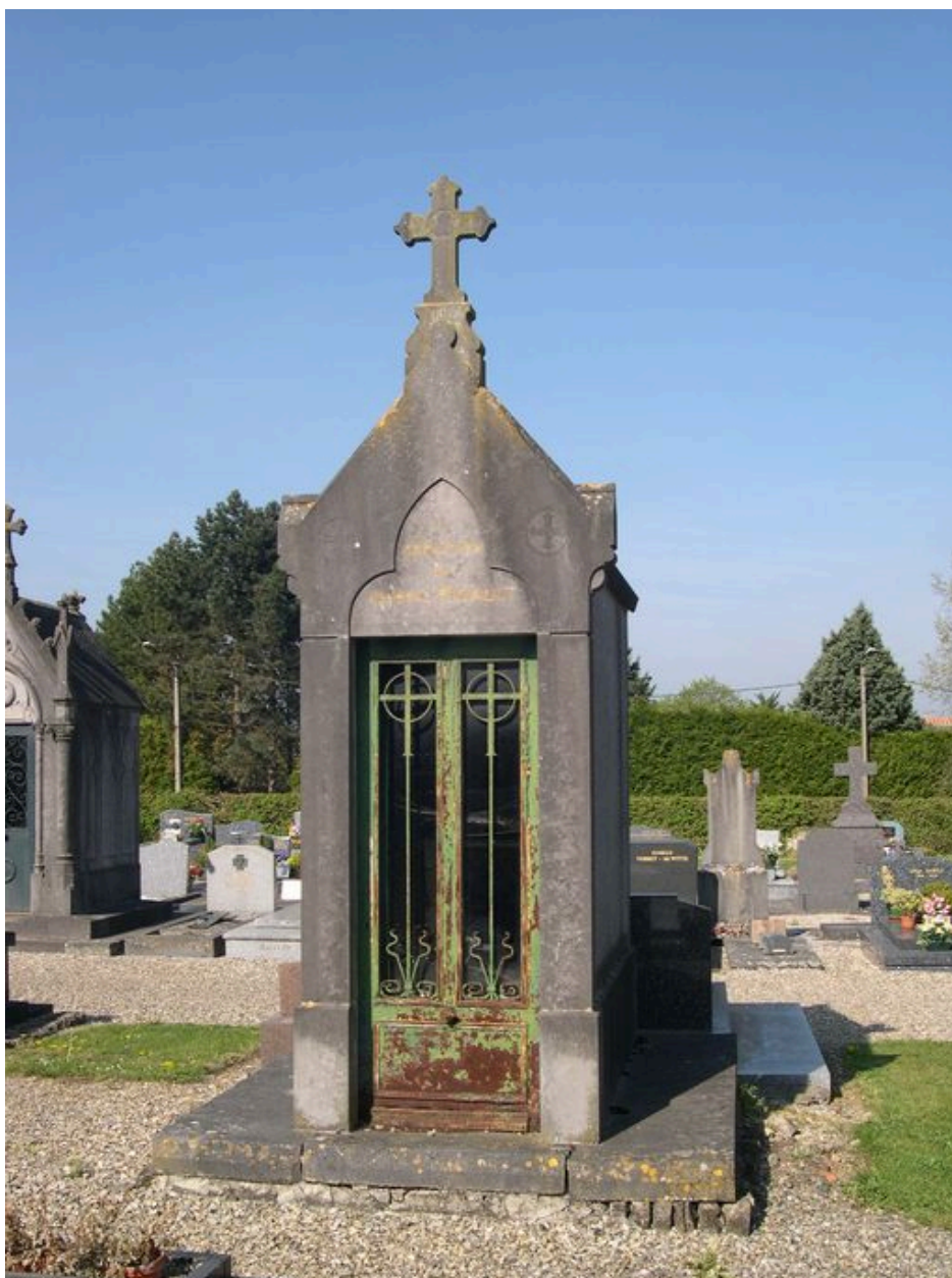
Tombeau (chapelle) exécuté par l'entrepreneur Rombaux Roland.
