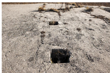
Toit de l'édifice. Les deux cheminée à périscopes Phot. Jean-Marc Ramette IVR31_20145904084NUCA
