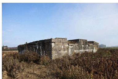
Elévation sud Phot. Jean-Marc Ramette IVR31_20145904081NUCA
