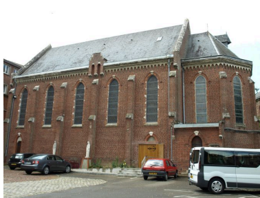
Chapelle : vue générale Phot. Bruno Decrock IVR31_20106208351NUCA
